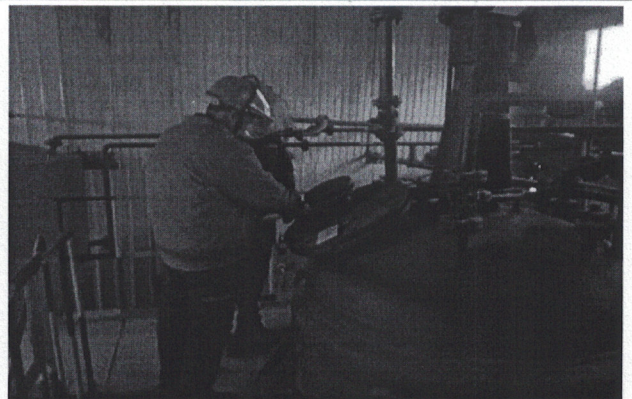
步骤 6 在泵区处相连接管线设置盲板
