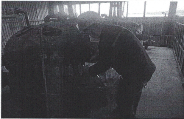
步骤 5 釜体相连接管线设置盲板
