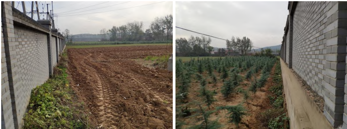
滨河 110kV 变电站（已建）站址及周边自然环境现状
