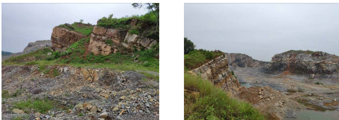
图 3.2-1 露天采场现状照片
