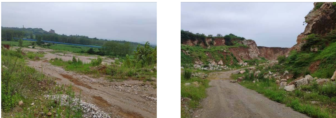
图 3.2-3 矿区道路现状照片
