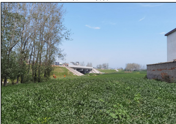
在建上罗高速（顶管）
