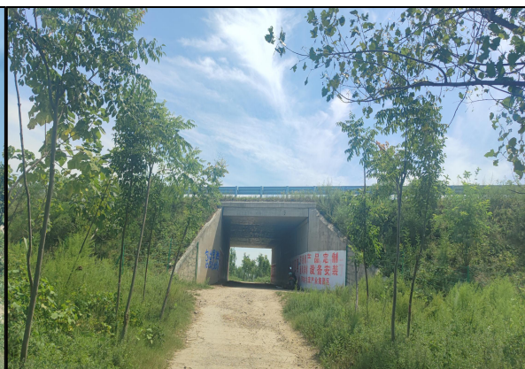
淮内高速（顶管）
