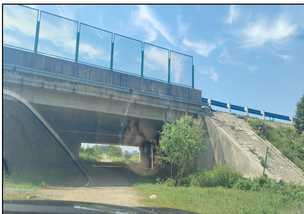
京港澳高速（顶管）
