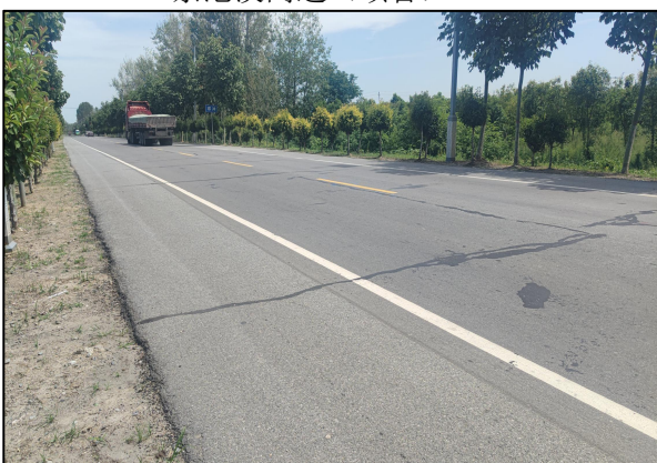
S335 邓冲（顶管）
