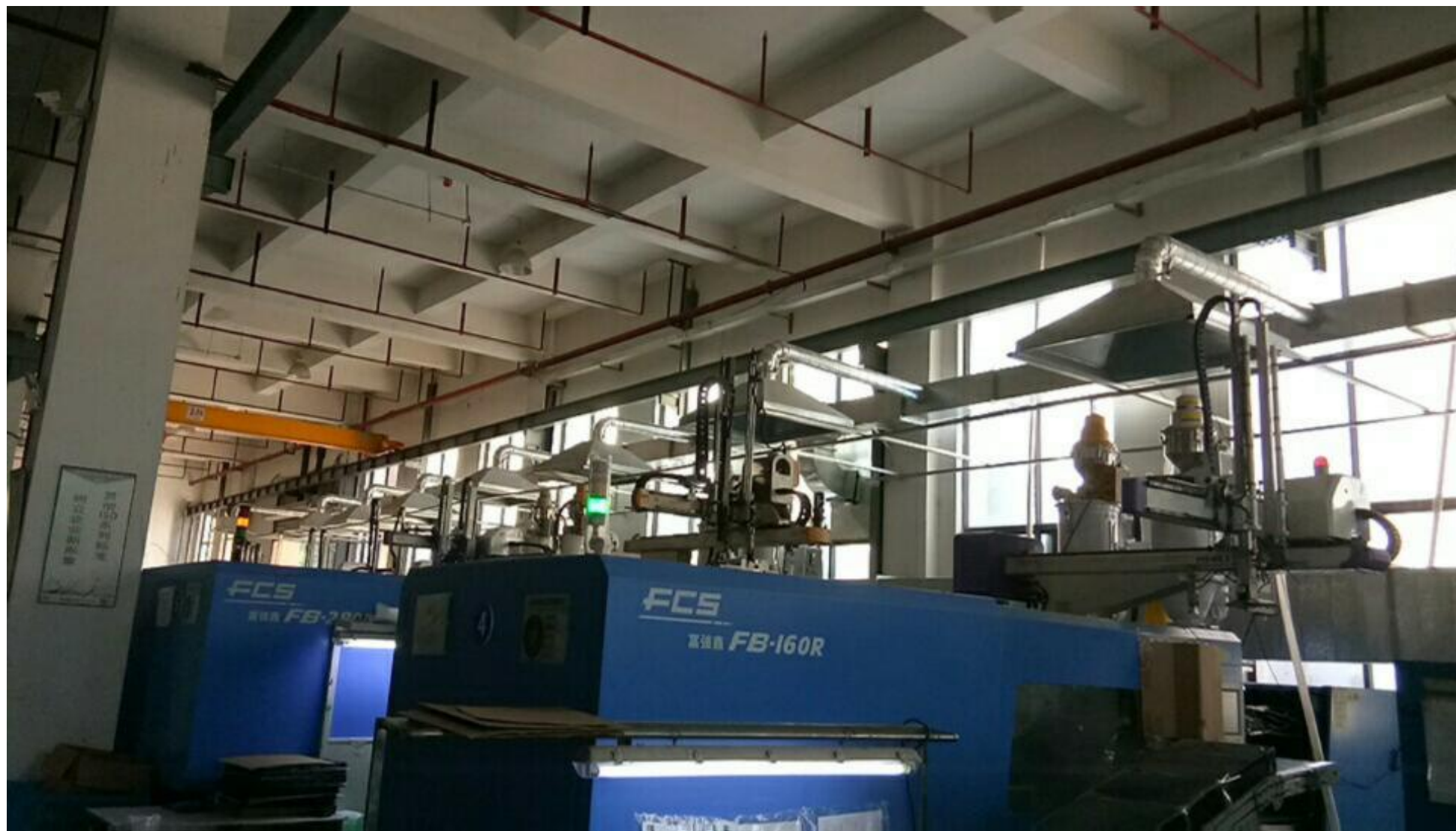
附图 6-2 废气处理设施实景图
