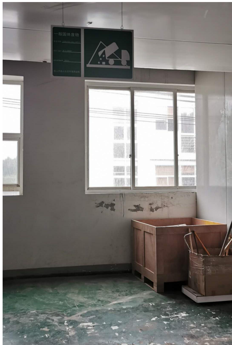
附图 4：项目一般固废暂存点
