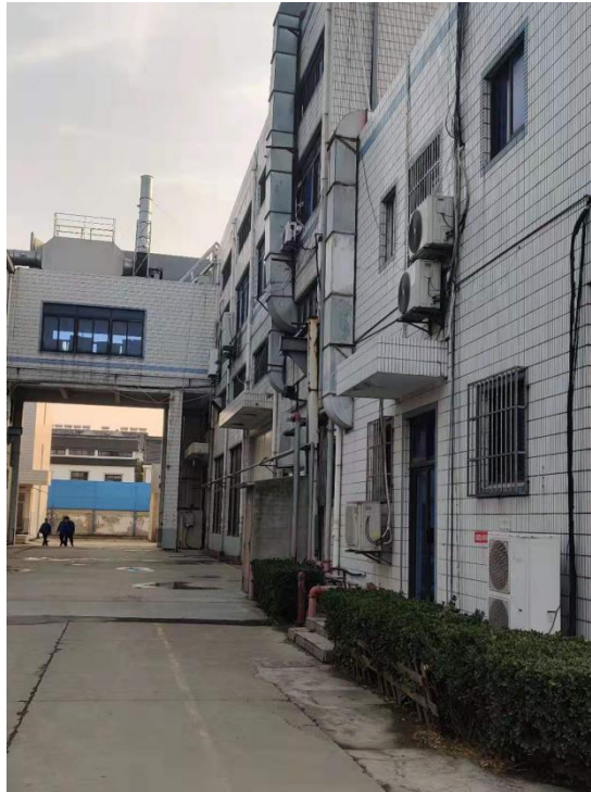
图 4.2-4 废气处理设施
