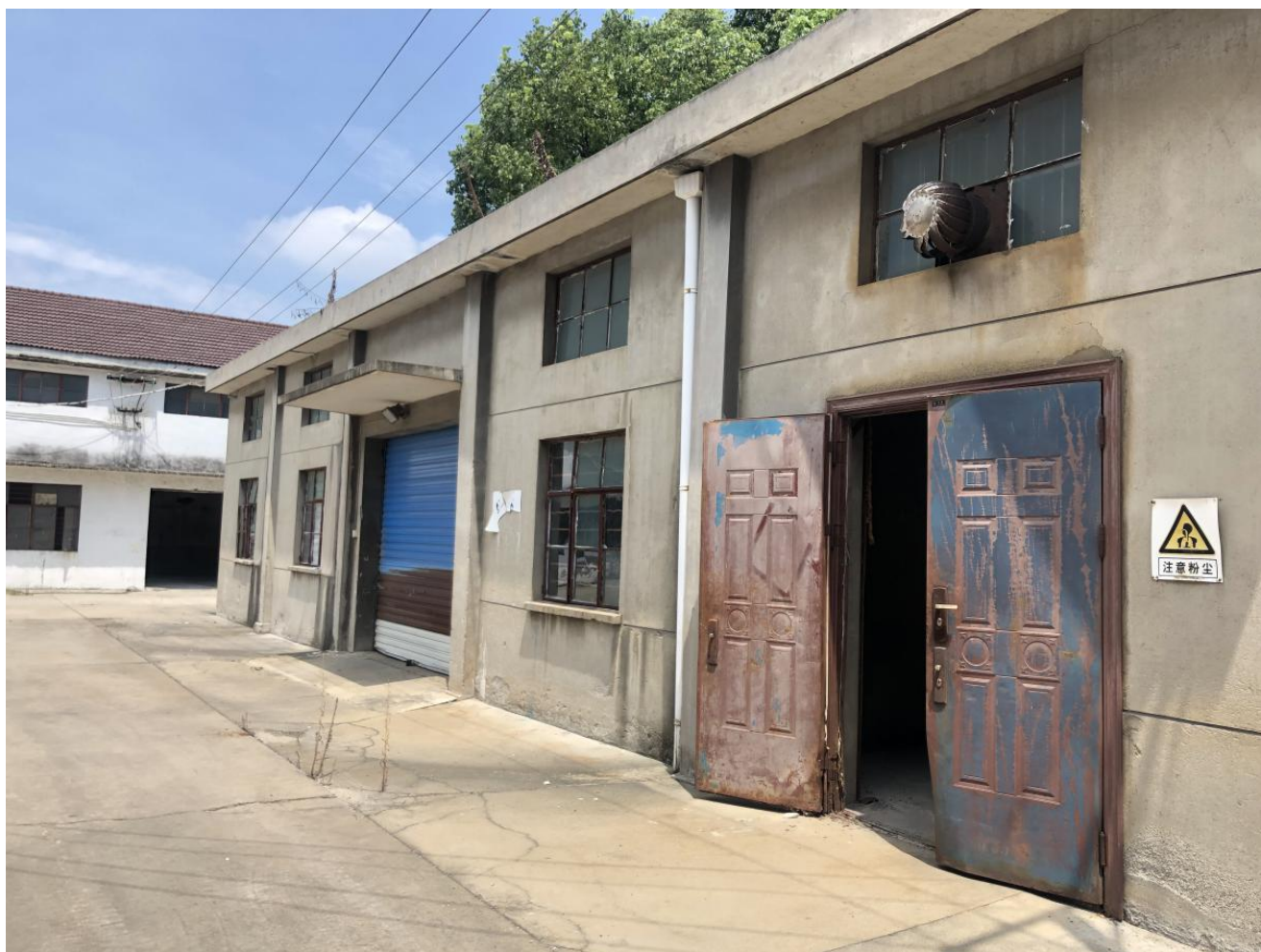
图2.3-18 地块内原料仓库外部现状图
