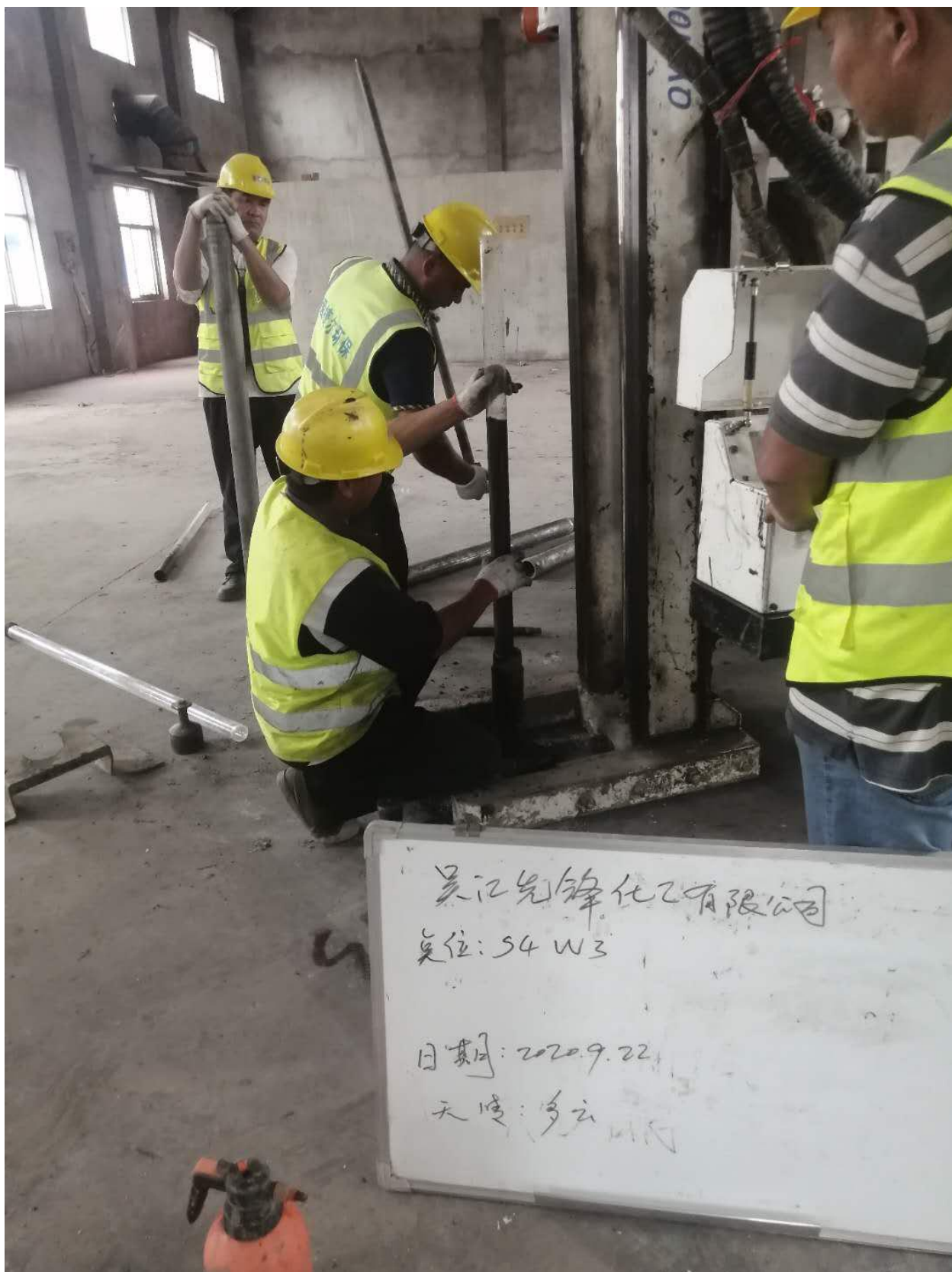
图4.2-3 Y-100L型土壤地下水修复一体钻机现场土壤钻孔
