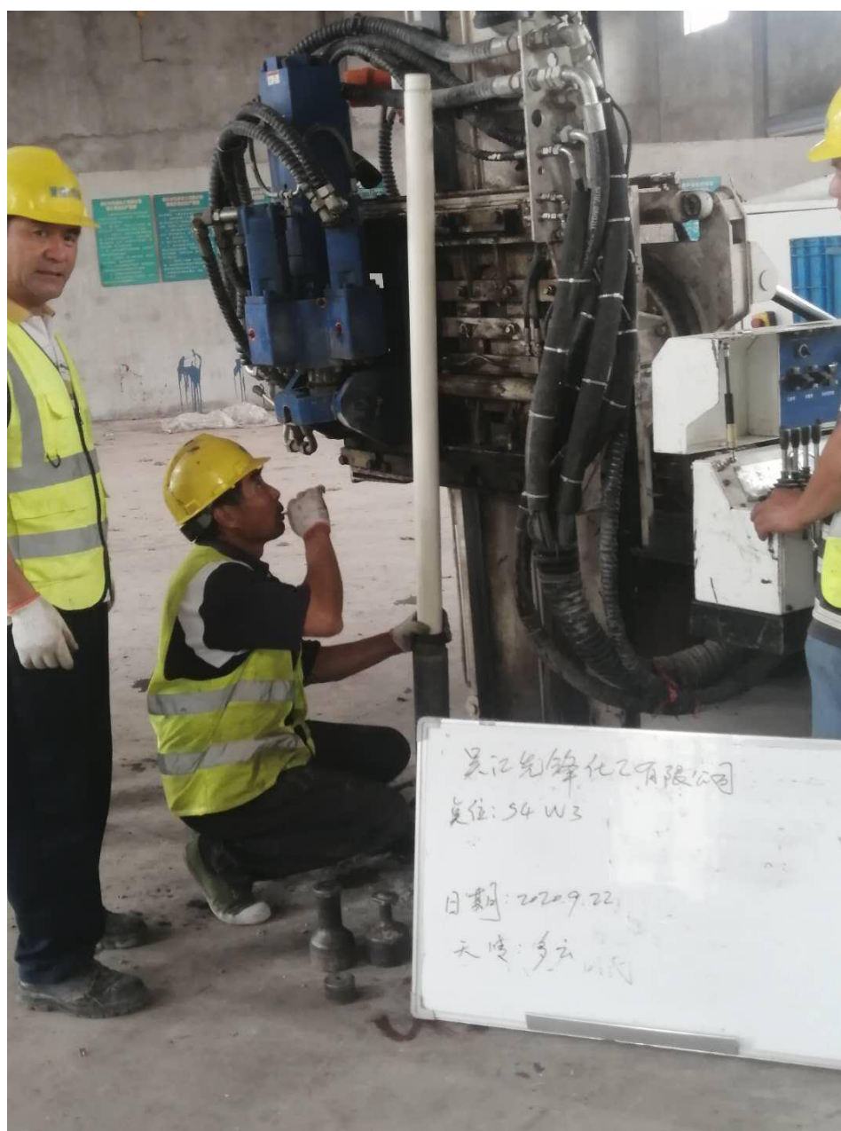
图4.2-11 地下水监测井下管图
