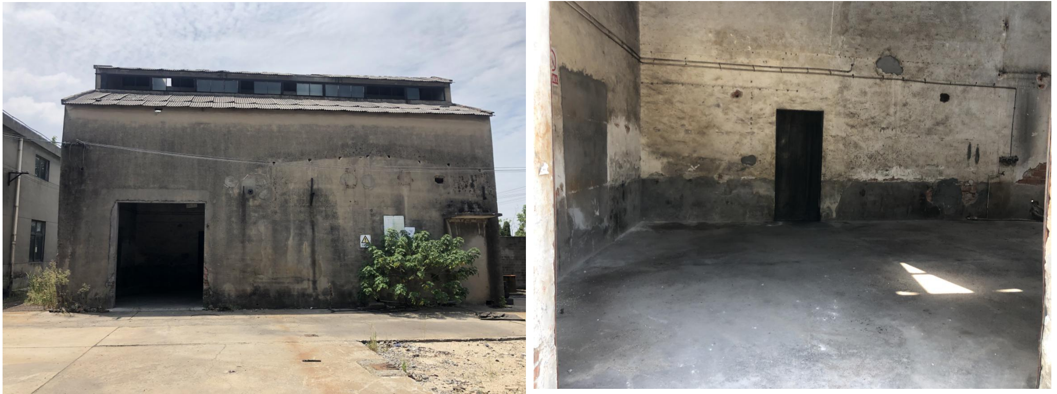
图2.3-21 地块内原锅炉房内外部现状图
