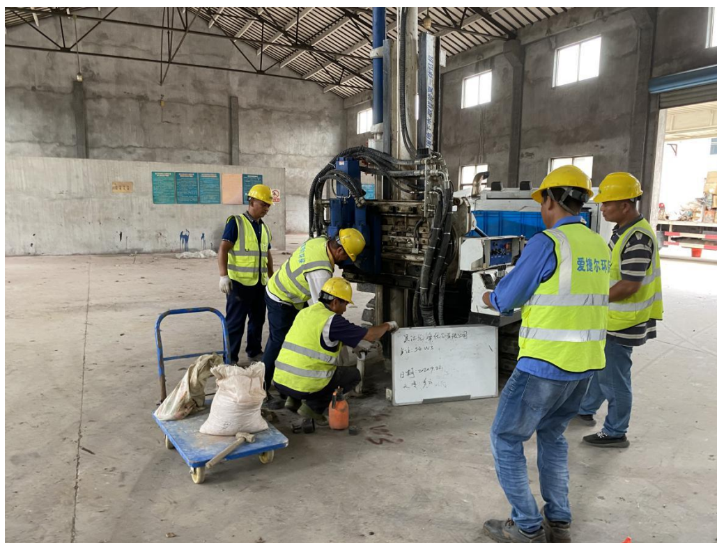
图4.2-13 填膨润土球图
