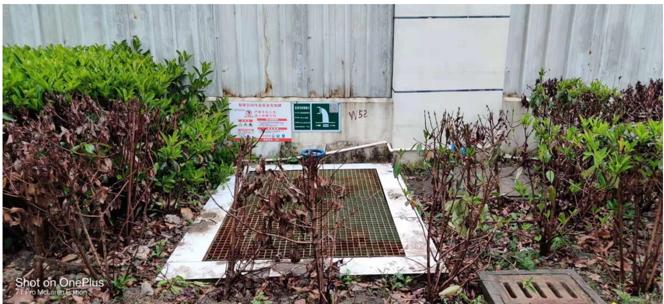
图5.1-18 生活污水排口
