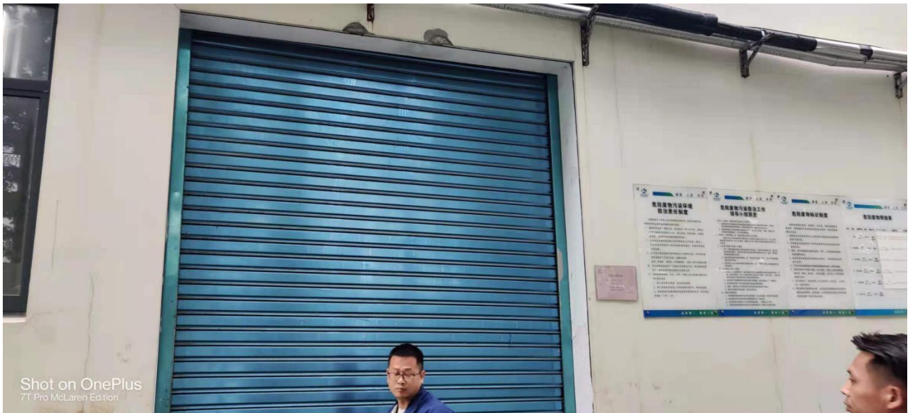
图5.1-21 危废仓库（外部）
