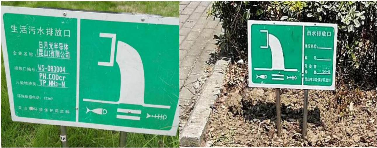
图5.1-7生活污水排口、雨水排口
