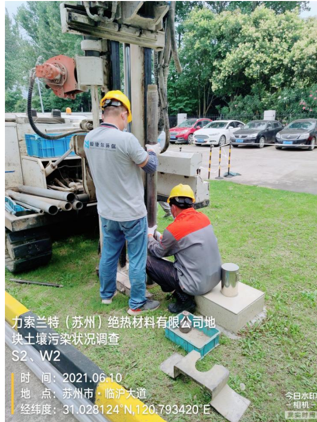
图4.2-2 QY-100L型土壤地下水修复一体钻机现场土壤钻孔
