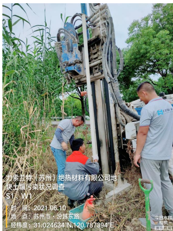
图4.2-12 地下水监测井下管图
