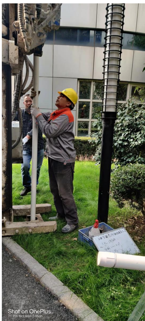
图4.2-9 地下水监测井下管图
