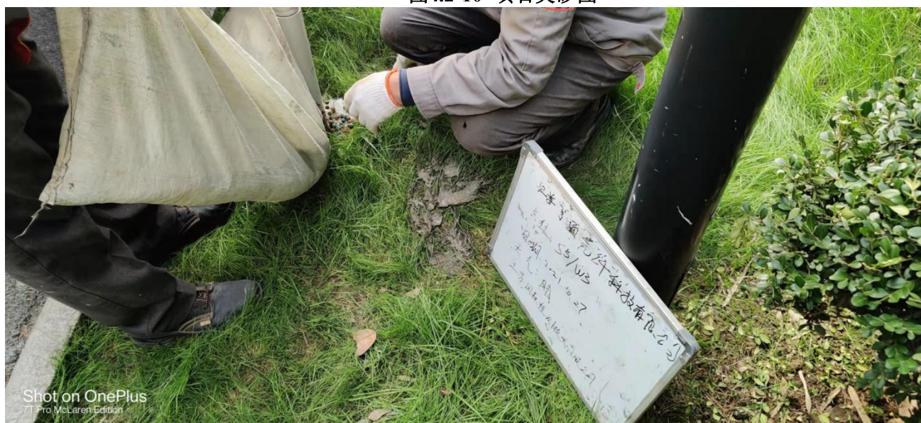
图4.2-11 填膨润土球图
