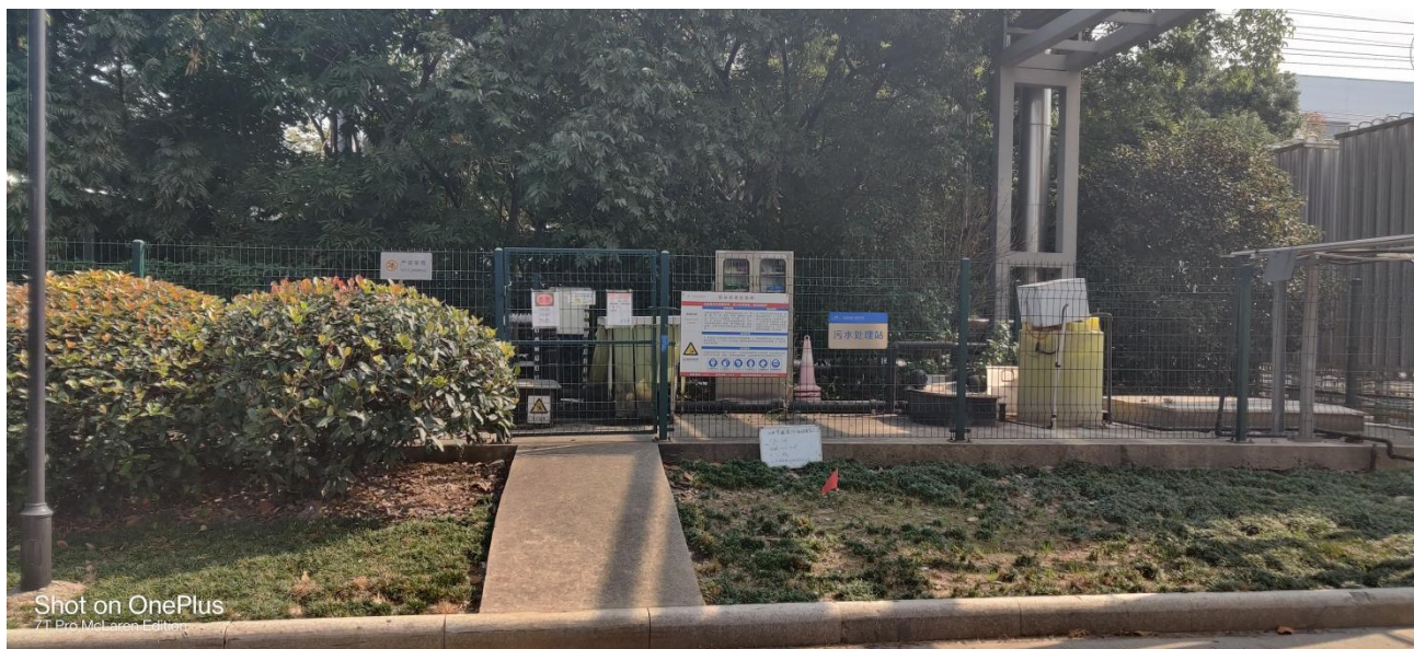
图5.1-2 生活污水处理站
