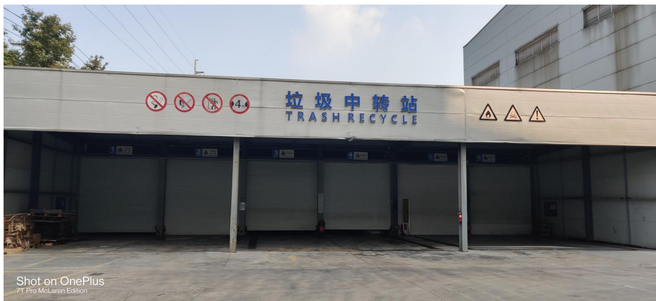
图5.1-9 危废仓库外部
