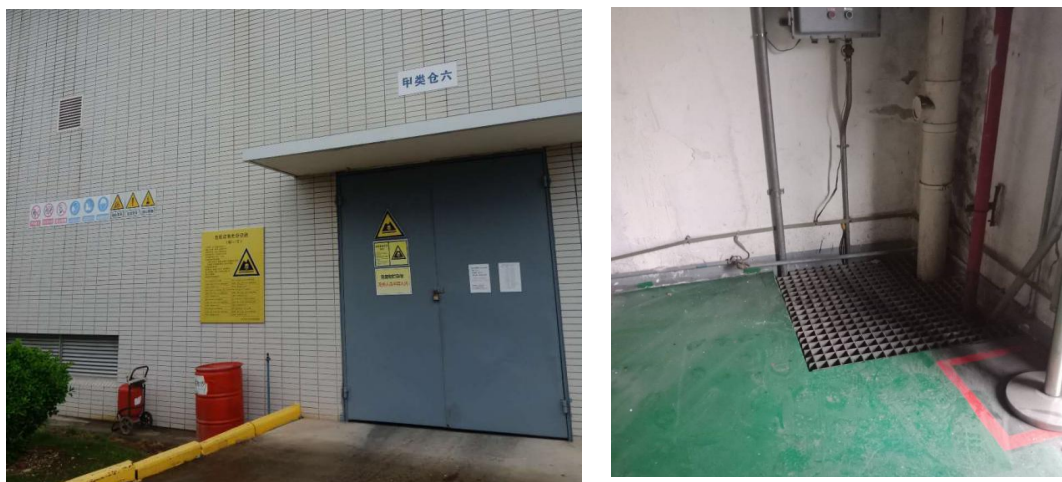
图 2.2-9 危废暂存场所现场图
