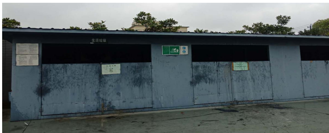
图 2.2-10 一般固废储存场所现场图
