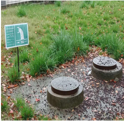
图 3.2-2 生活污水排放口
