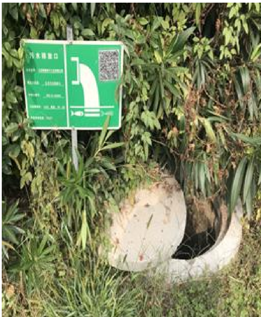
图5.1-18 生活污水排口
