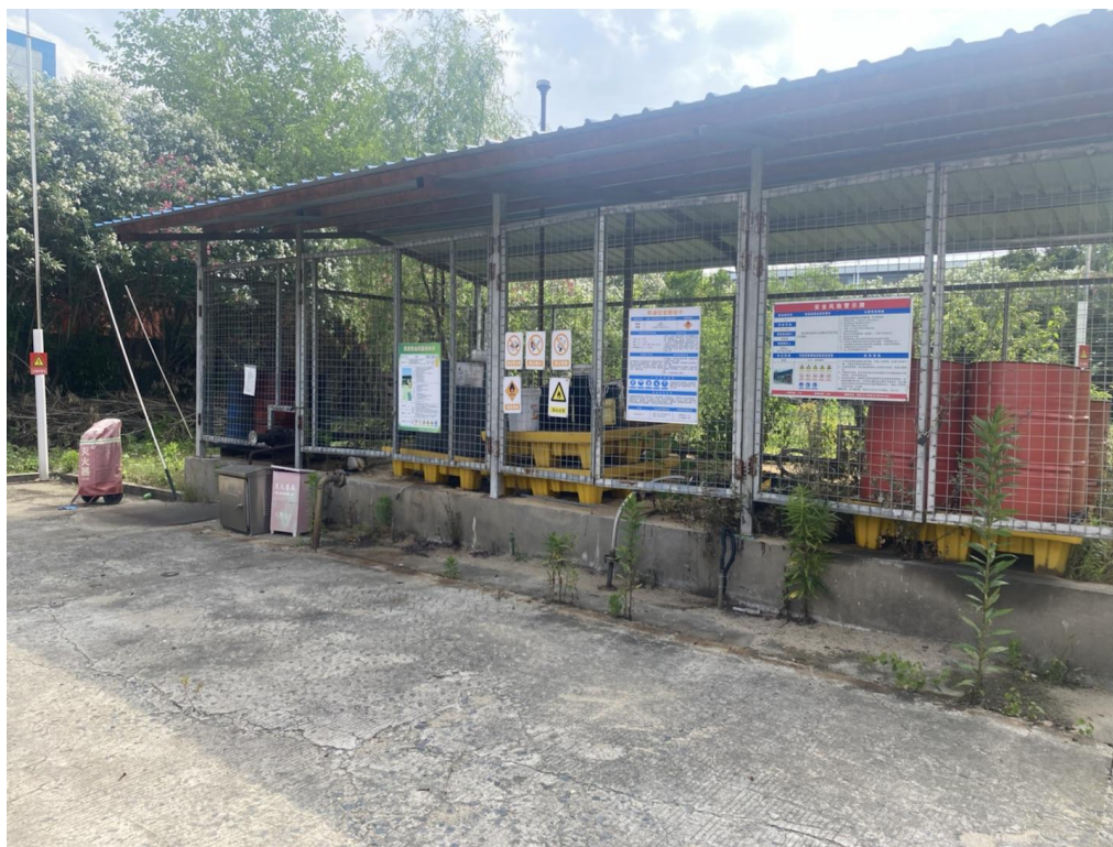
图5.1-4 地下柴油储罐区
