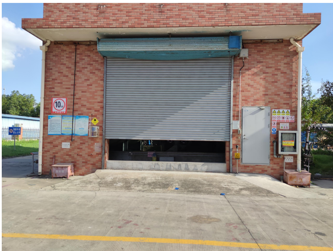
图5.1-8 溶剂房装卸区
