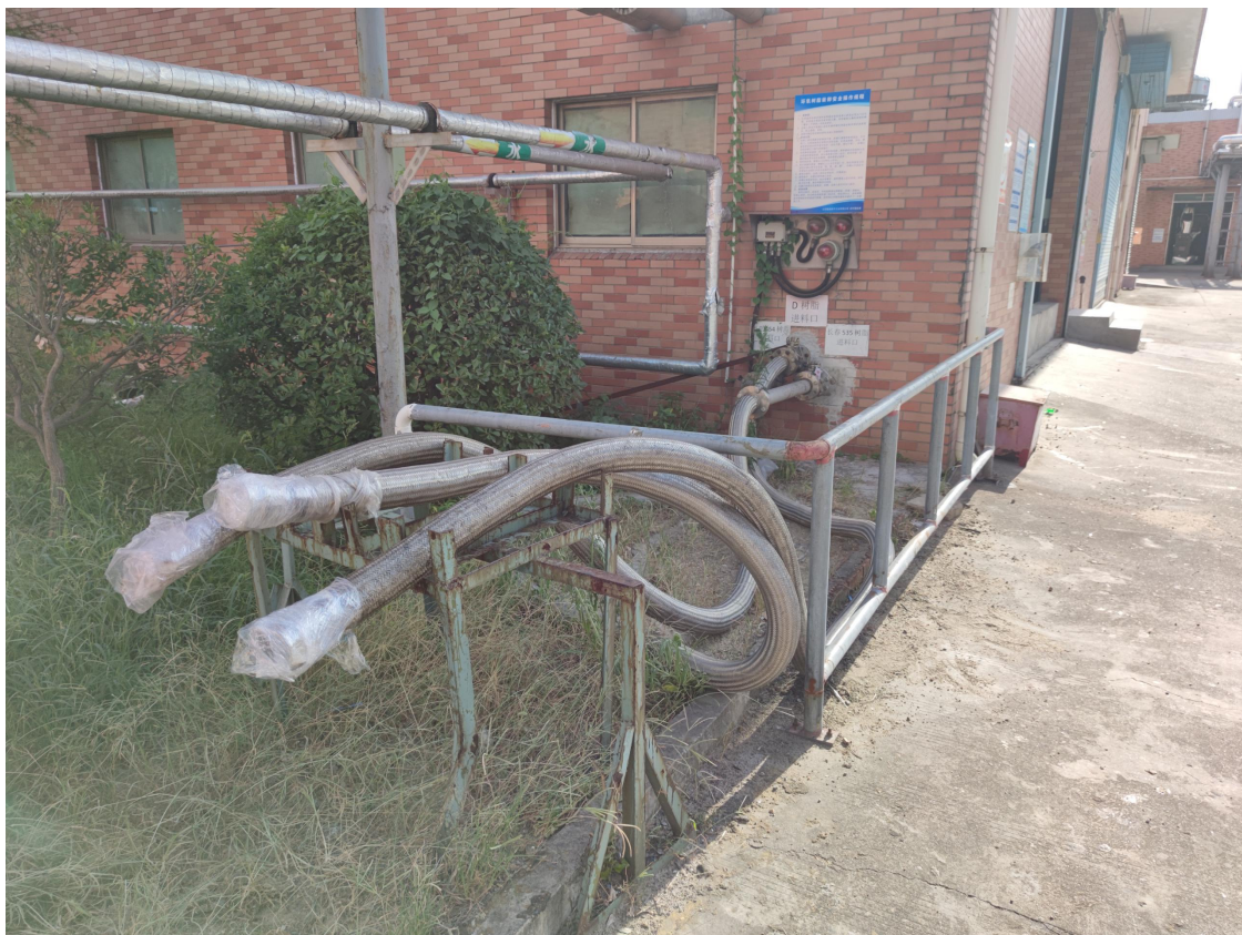
图5.1-7 槽装树脂房装卸区
