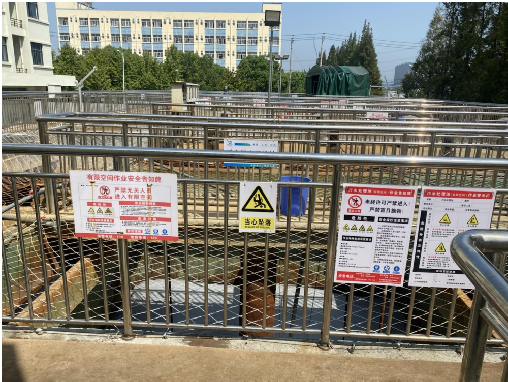
图5.1-2 废水处理站池
