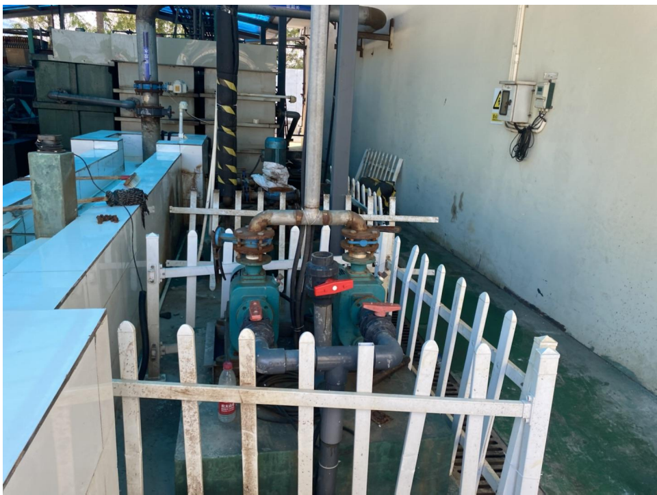
图5.1-6 生产废水传输泵
