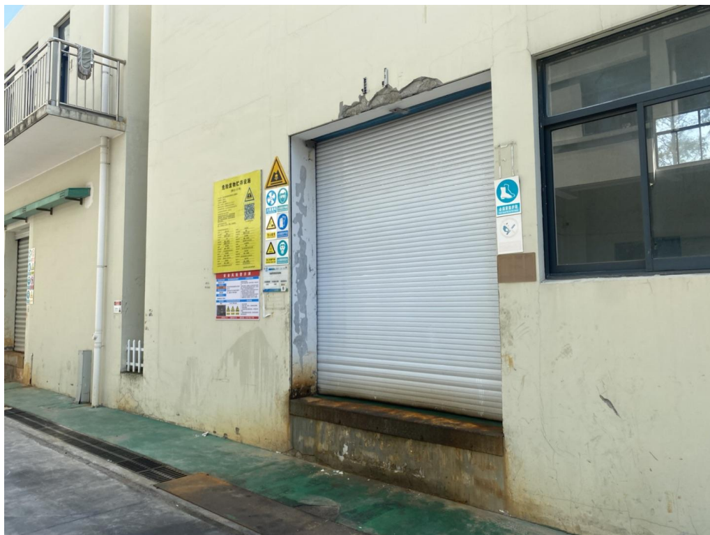
图5.1-25 危废仓库（外部）
