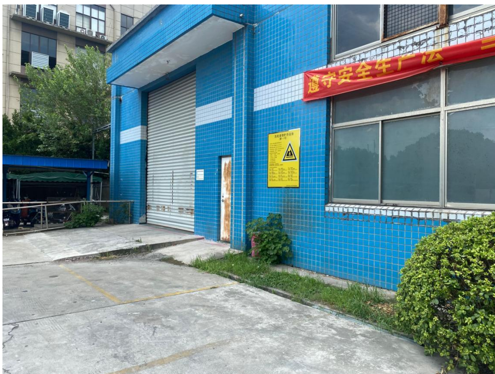
图5.1-15 危废仓库外部
