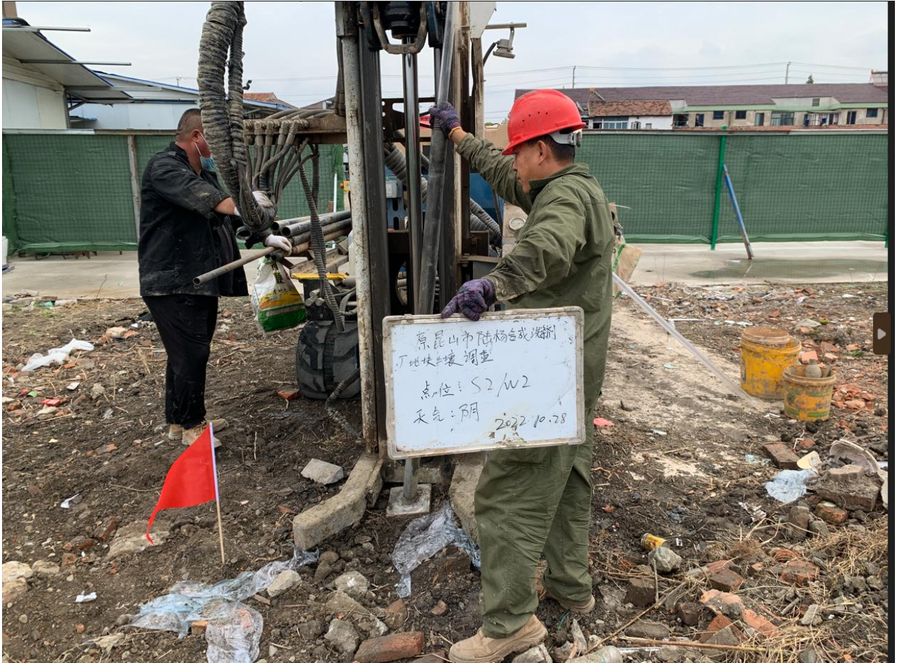
图3.2-2 QY-100L型土壤地下水修复一体钻机现场土壤钻孔
