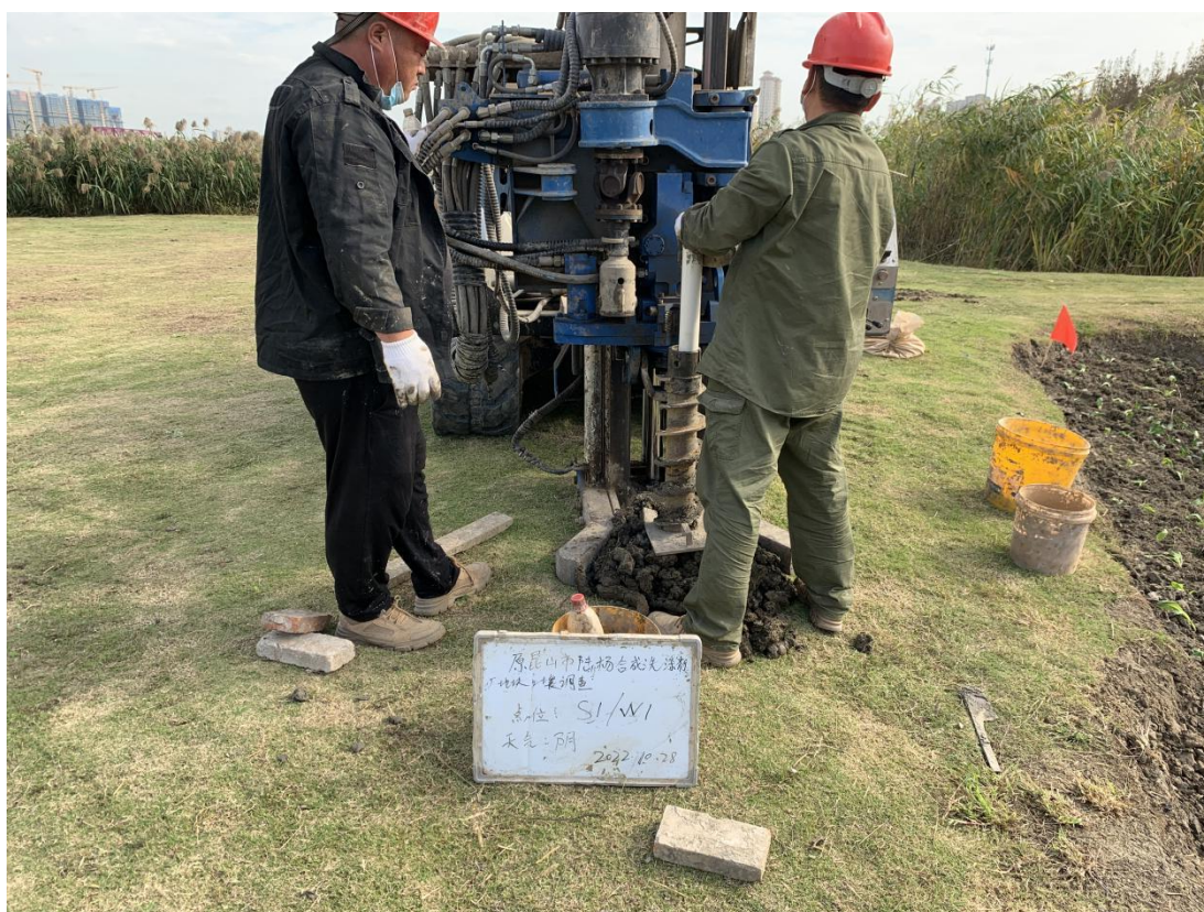
图3.2-12 地下水监测井下管图
