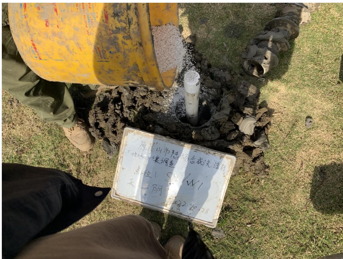
图3.2-13 填石英砂图
