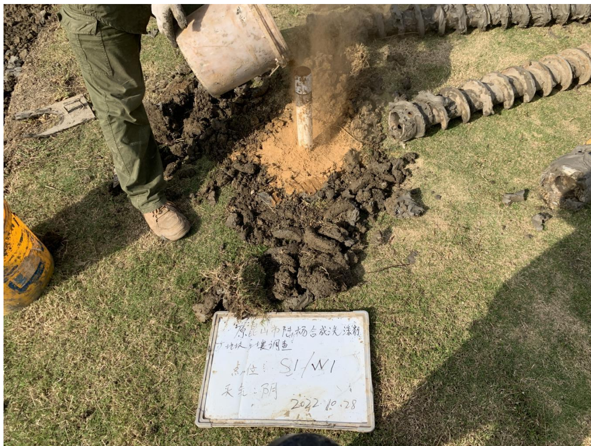
图3.2-13 填膨润土球图
