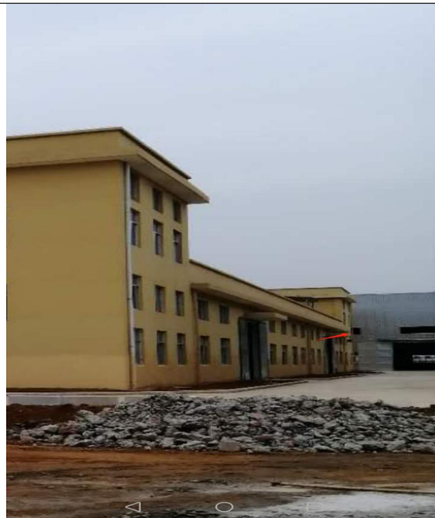
整改前二车间片钒炉废气排口照片
