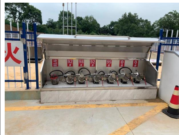
图 2-6 油气回收装置图
