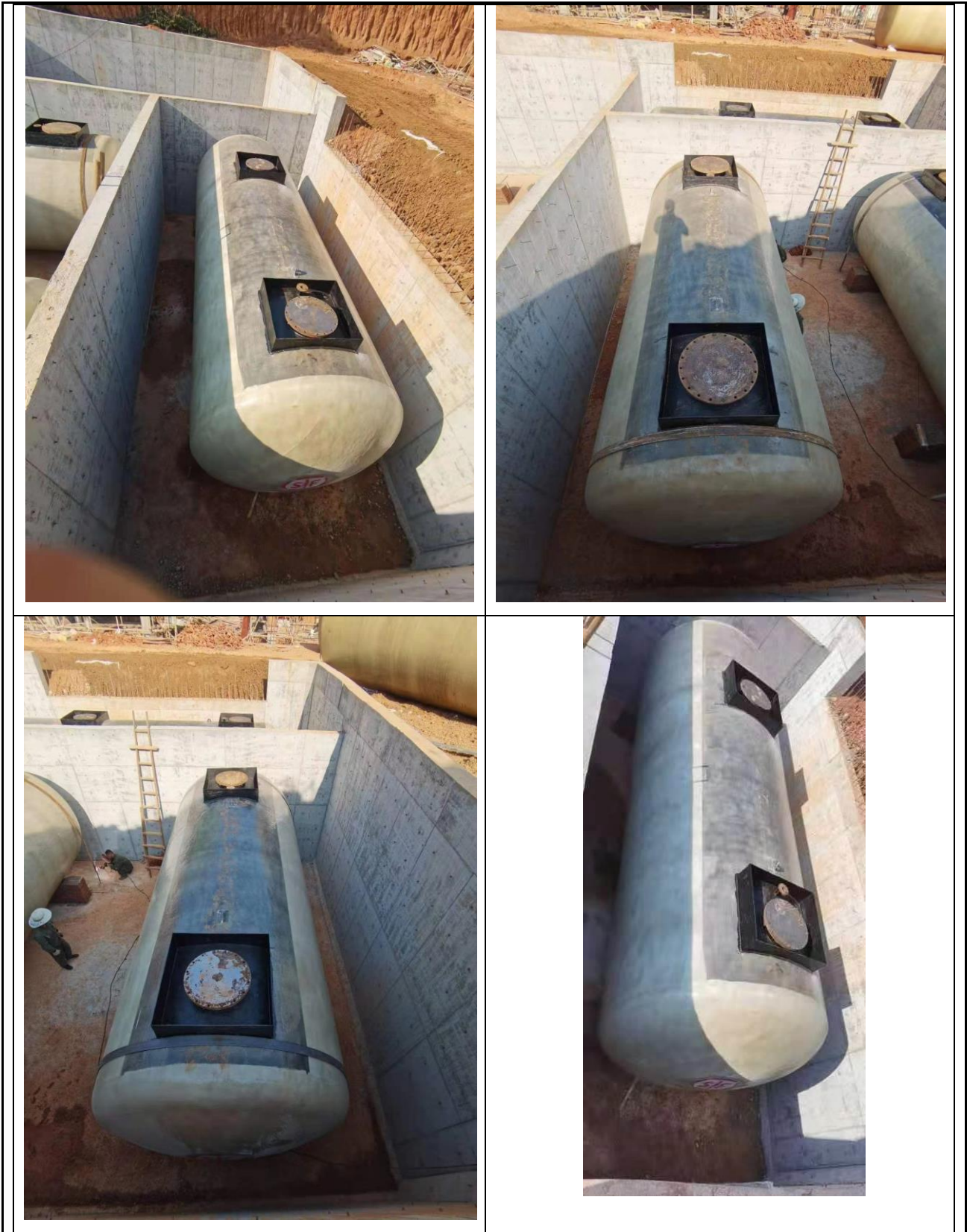
图 2-3 双层卧式油罐施工图
