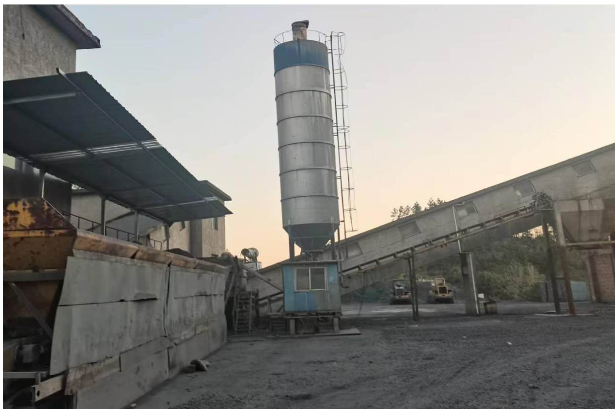
混凝土生产线
