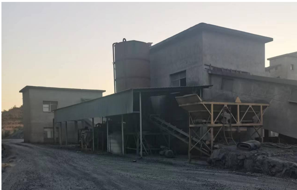
混凝土生产线
