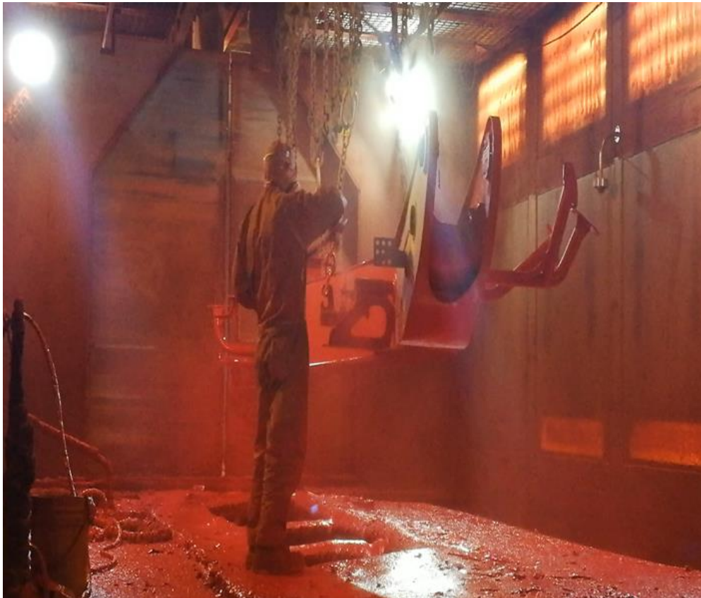
改造前-空气辅助式喷涂
