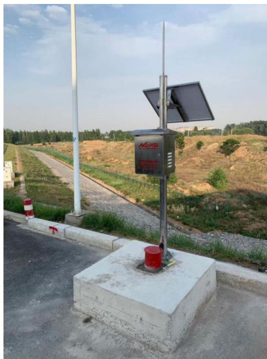
图 5.3-2 阵列位移计太阳能供电方式安装完成图
