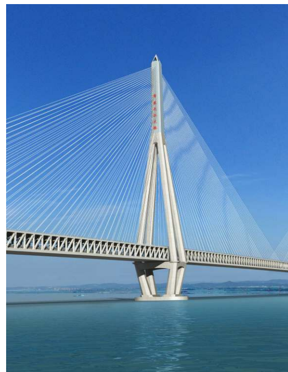
桥梁倾斜监测
