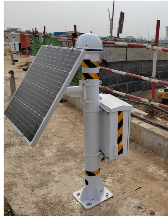
建筑基坑位移监测
