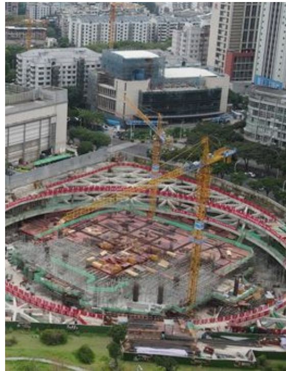
建筑基坑安全监测
