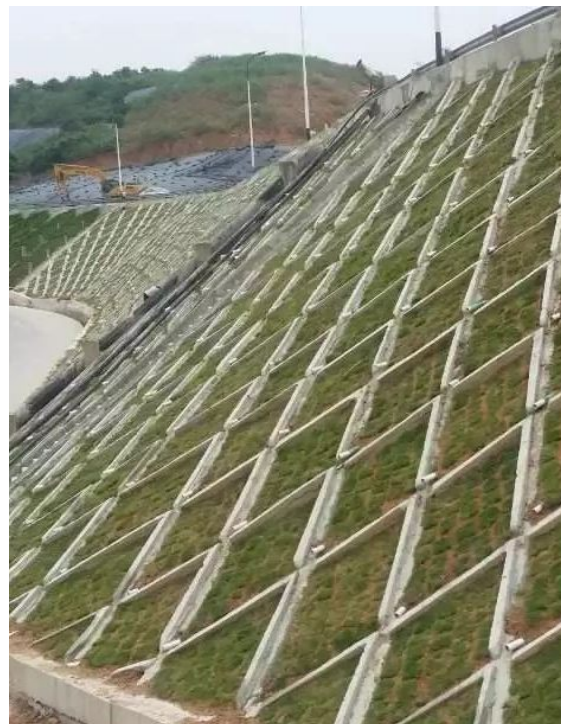
边坡安全监测
