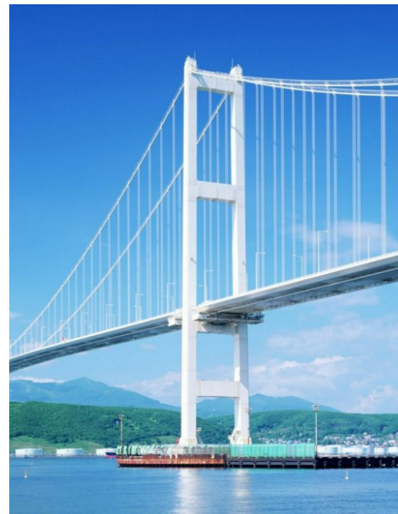
桥梁安全监测
