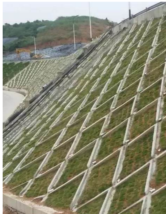
边坡安全监测
