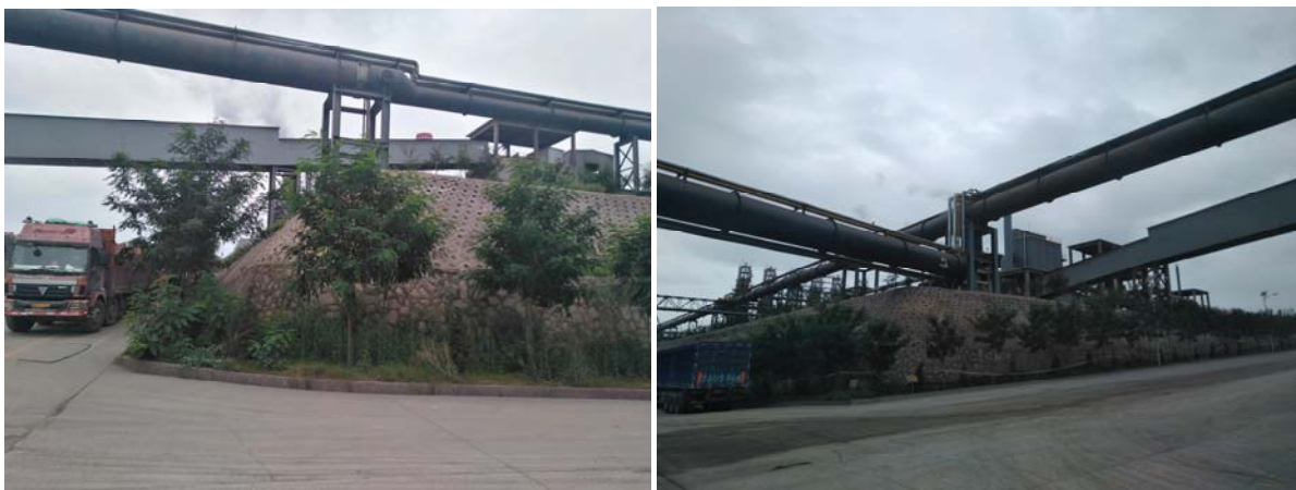
照片 8：2018 年 7 月 22 日-监理对浆砌石挡土墙与护坡周边绿化调查
