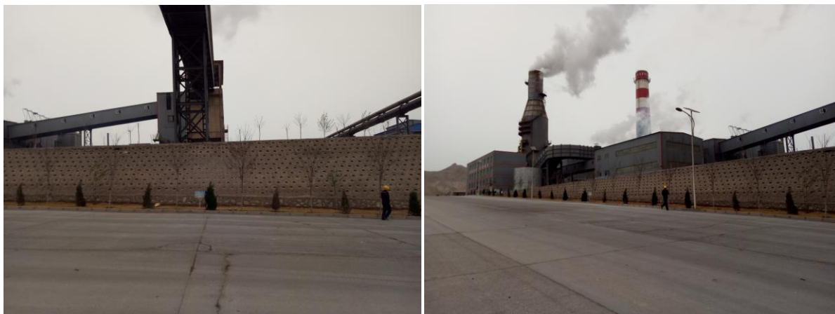
照片 2：2018 年 1 月 26 日-浆砌石挡土墙、预制透水砼块护坡情况调查
