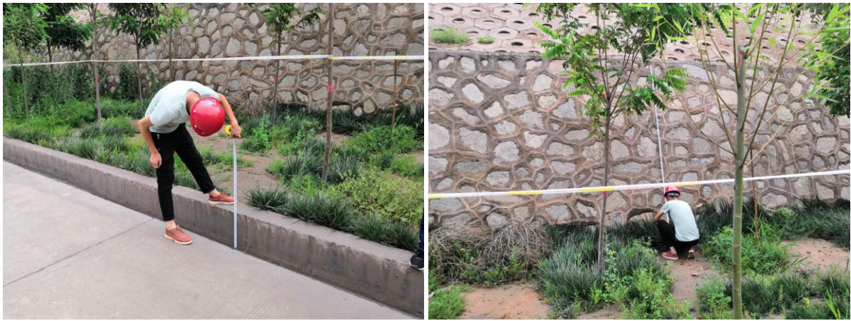
照片 13：2018 年 9 月 17 日-监理对排水与浆砌石挡土墙与护坡情况调查
