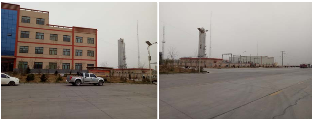
照片 3：2018 年 1 月 26 日-办公楼与变电站周边绿化情况调查
