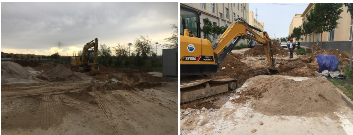
照片 4：2018 年 4 月 15 日-监理对部分场地平整与排水施工调查
