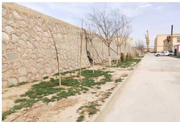
生产区浆砌石挡土墙
