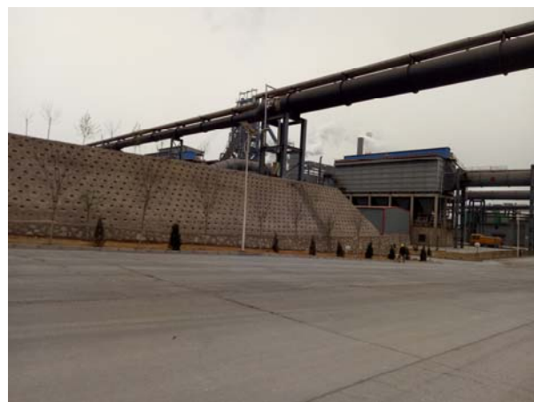
浆砌石挡土墙与预制透水砼块护坡护
