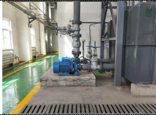
水泵类设备基础减震
