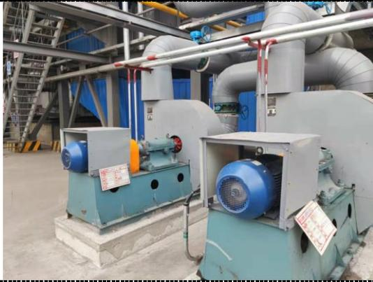
风机类设备基础减震及隔音罩等降噪措施
