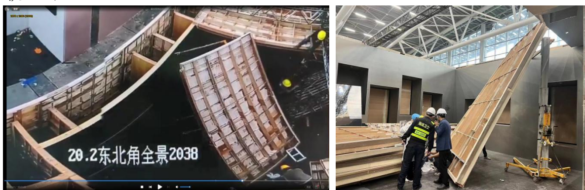
图 4 事发后作业现场情况
