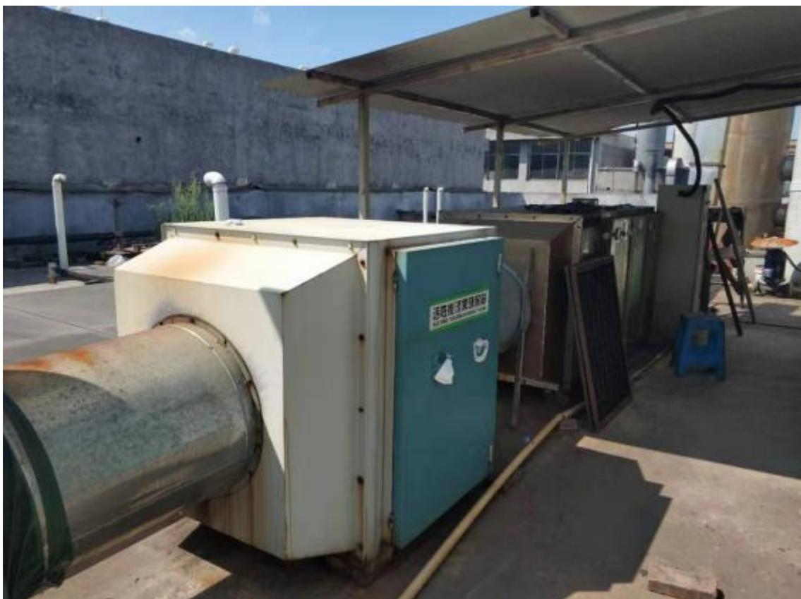
图 4-6 烘干废气处理装置（水喷淋+脱水分离+光催化氧化+活性炭吸附）
