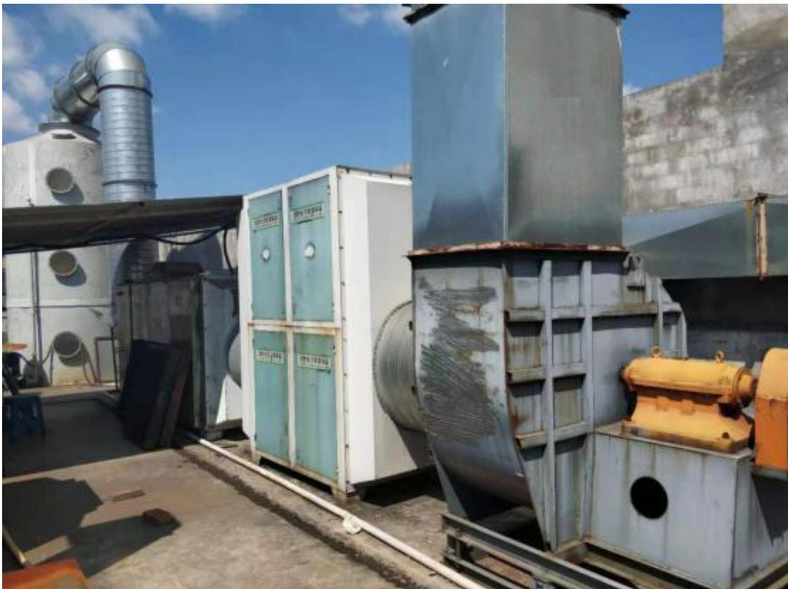
图 4-5 喷漆废气处理装置（水喷淋+脱水分离+光催化氧化+活性炭吸附）
