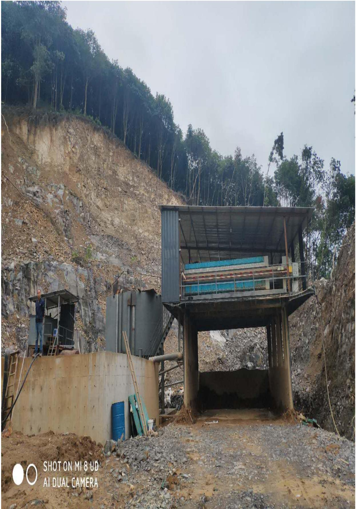
污水处理设施（混凝沉淀加板框压滤工艺）
