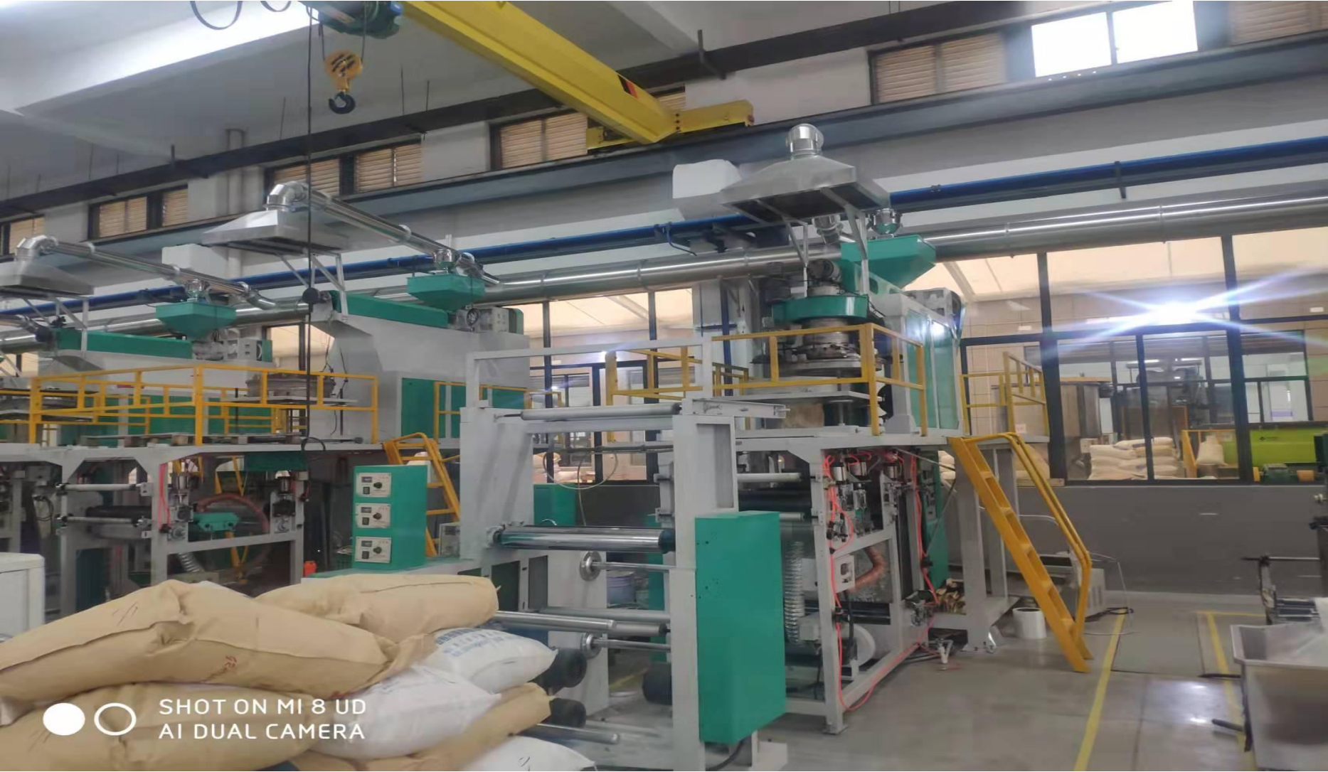
吹膜废气产生源及收集装置
