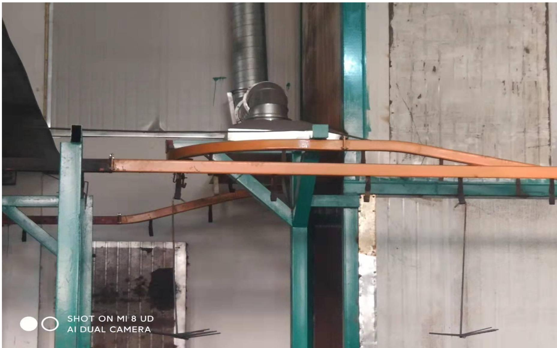
烘干废气和液化气燃烧废气产生源及收集装置（集气罩收集）
