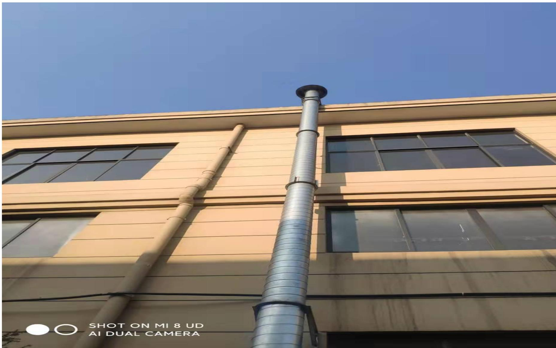
注塑废气排气筒出口
