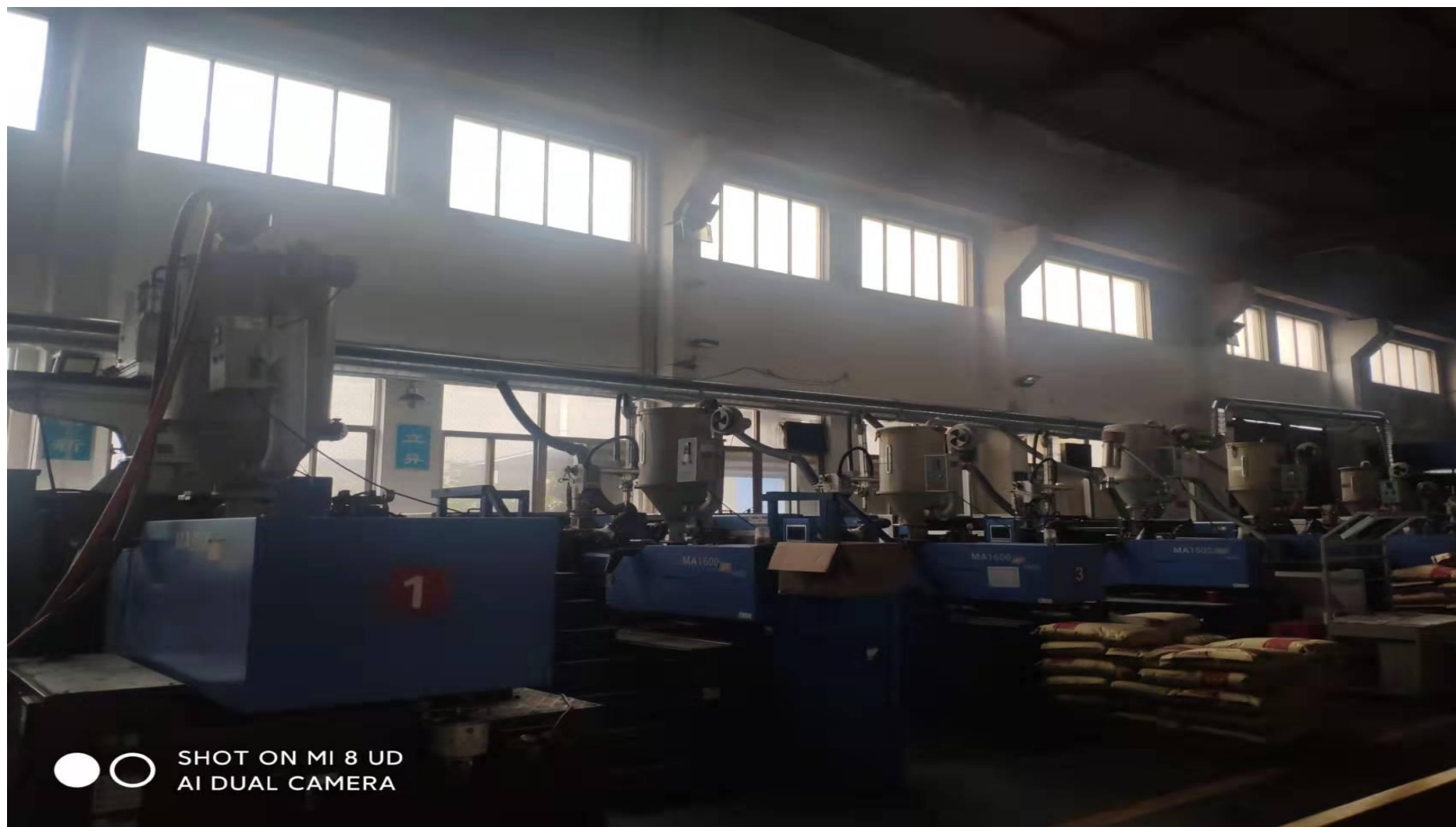
注塑废气产生源及收集装置
