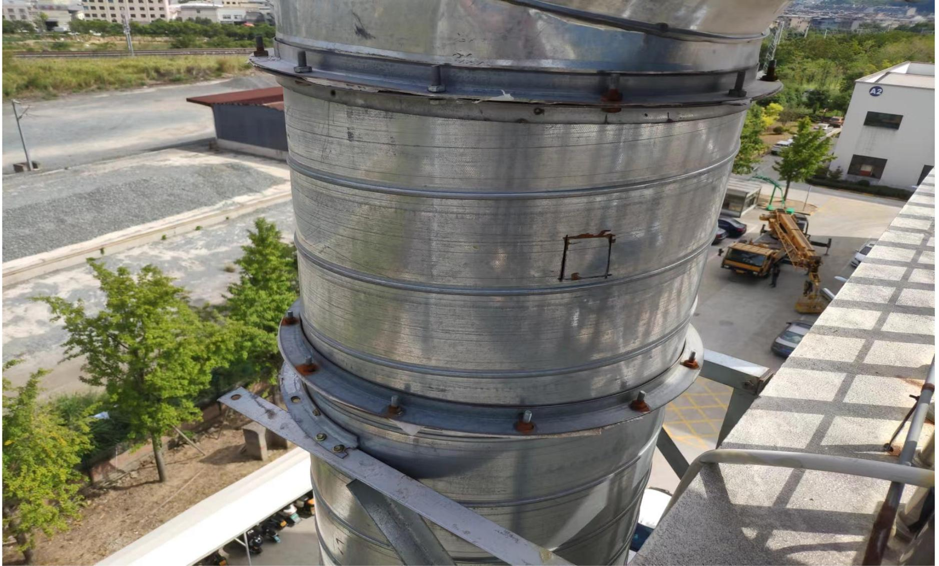
注塑废气排气筒采样口
