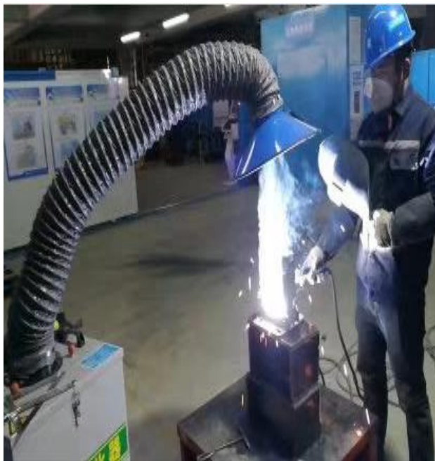
附图 5 项目现场检测照片（2）
