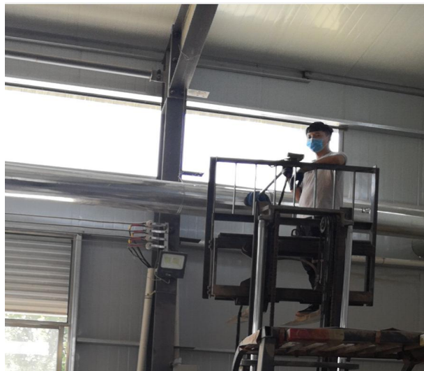
附图3 项目现场检测照片(1)
