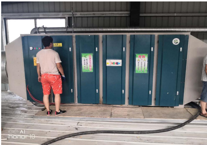
附图 4 项目现场照片
