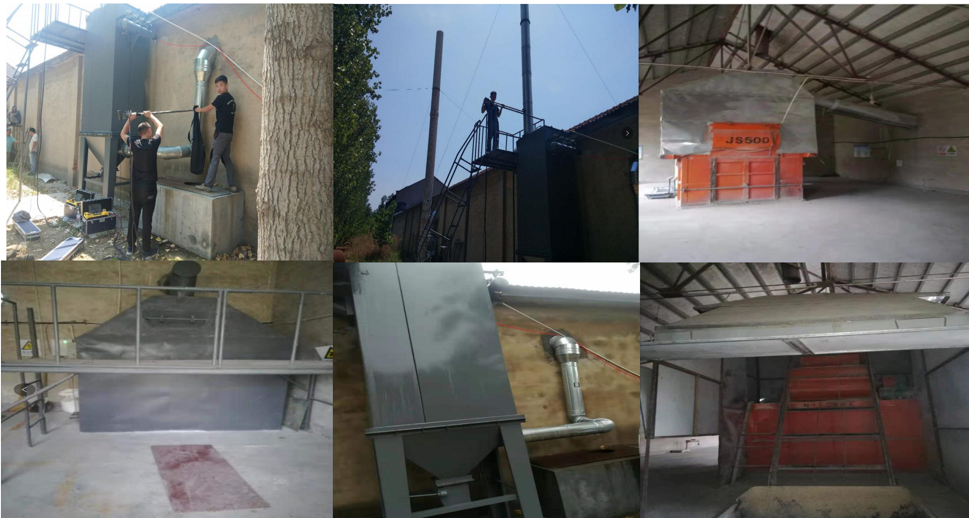
附图4 项目现场照片
