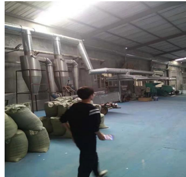
项目现场生产设备照片
