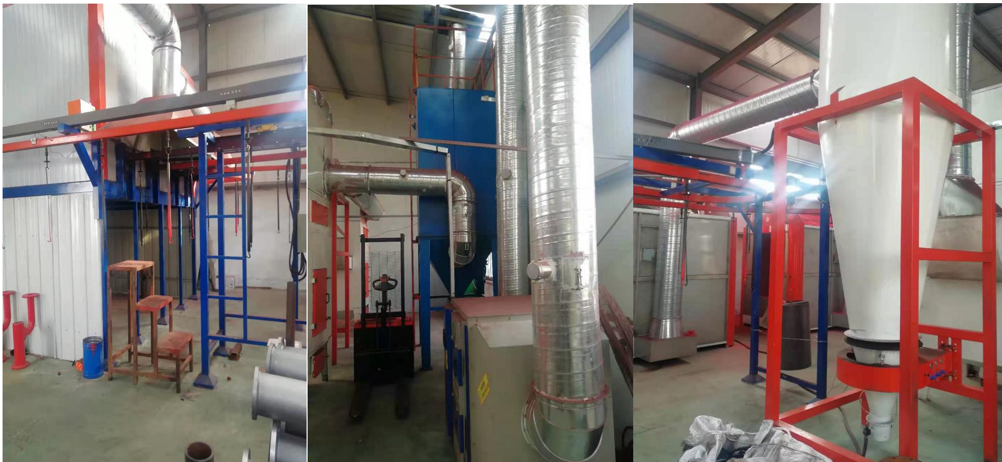
附图4 项目现场照片
