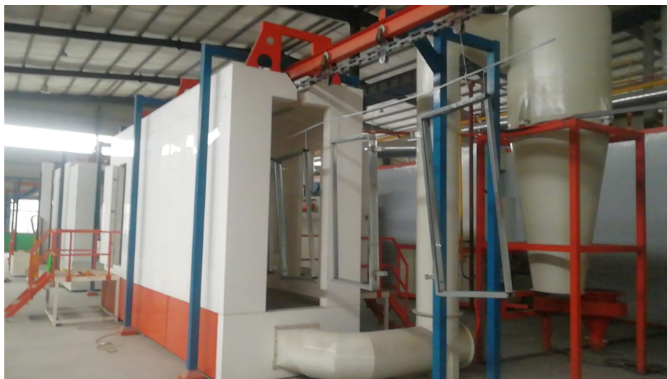
附图 4 项目现场照片
