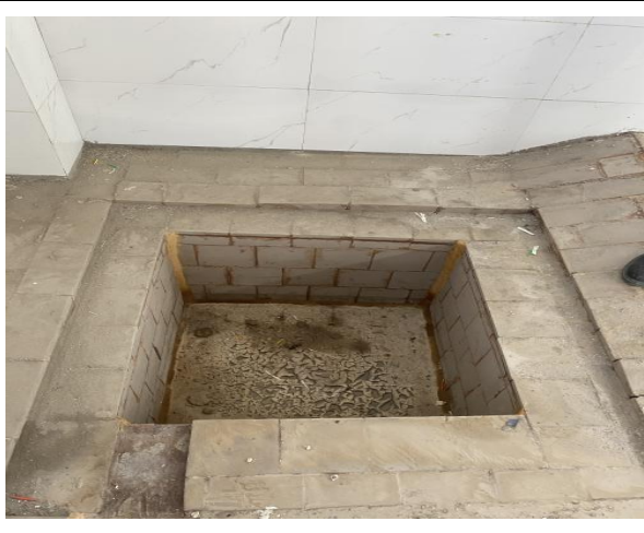
危废暂存库积液池
