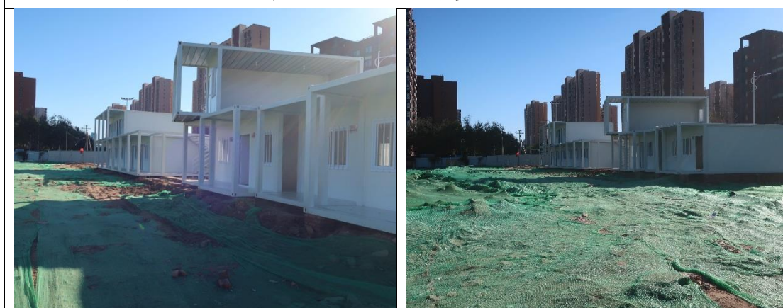
项目区东南侧未搭建完成的施工临建（2021.11）
