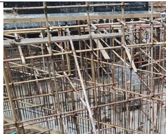
雨水调蓄池施工（2022.7）
