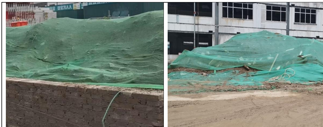
临时堆土临时覆盖（2022.7）
