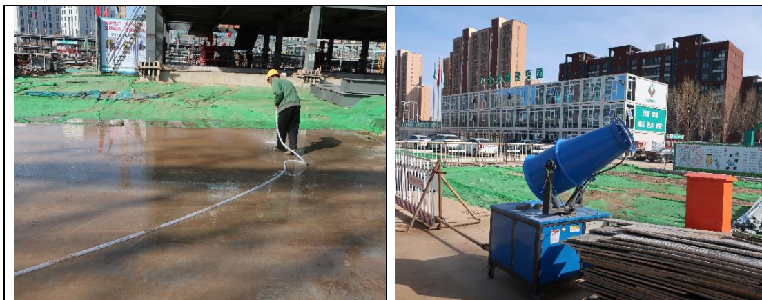
洒水降尘装置及人工洒水降尘（2022.3）
