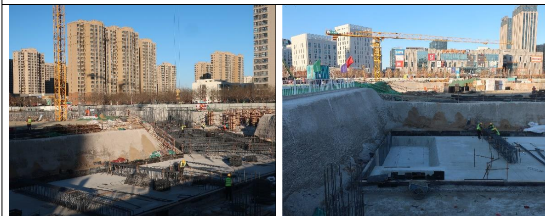
基坑边坡防水帷幕（2021.12）
