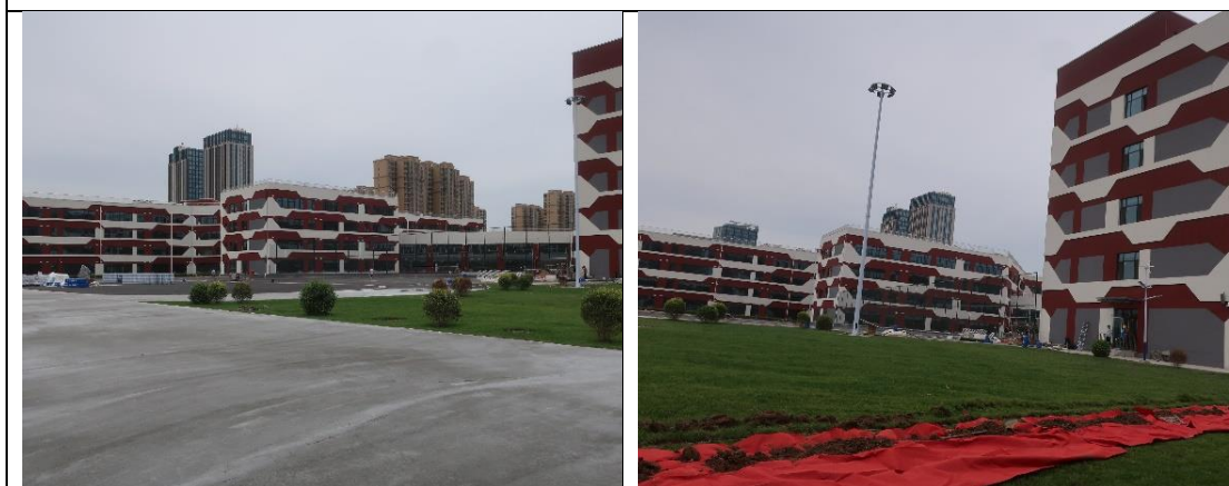
建筑物区教学办公综合楼（2022.9）
