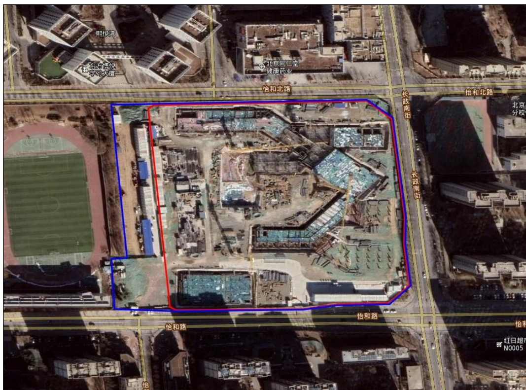
建筑物主体施工阶段遥感影像图（2022 年 2 月 5 日）
