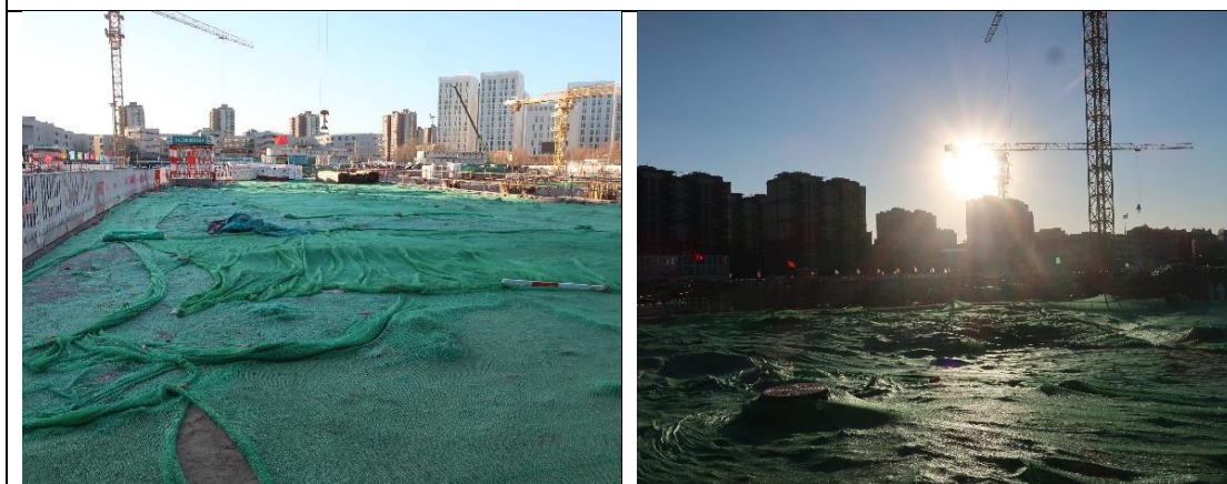
道路广场区临时覆盖 2 (2021.12)
