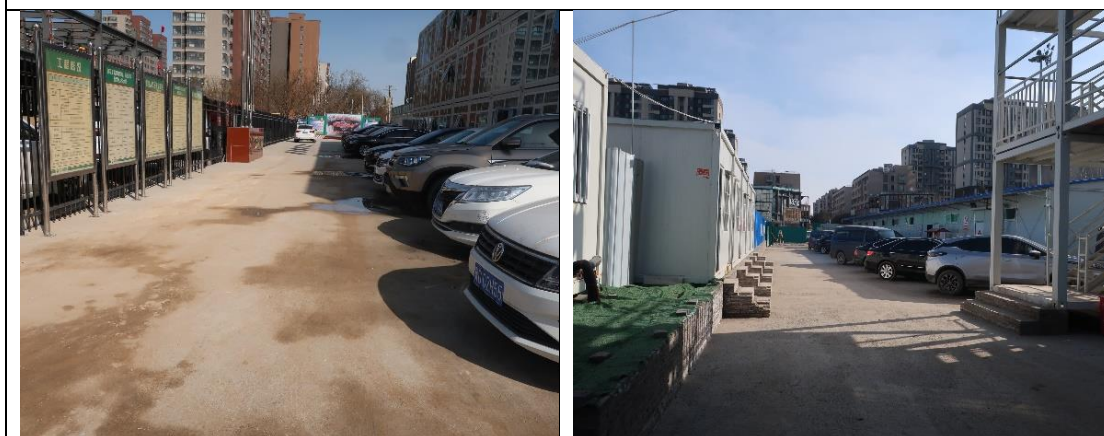
施工临建区临时硬化地面（2022.3）
