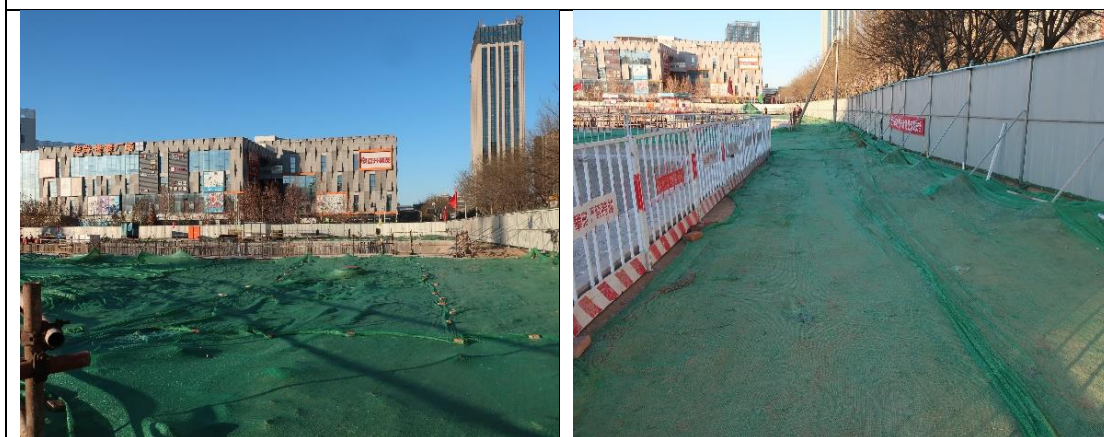
道路广场区临时覆盖 1 (2021.12)
