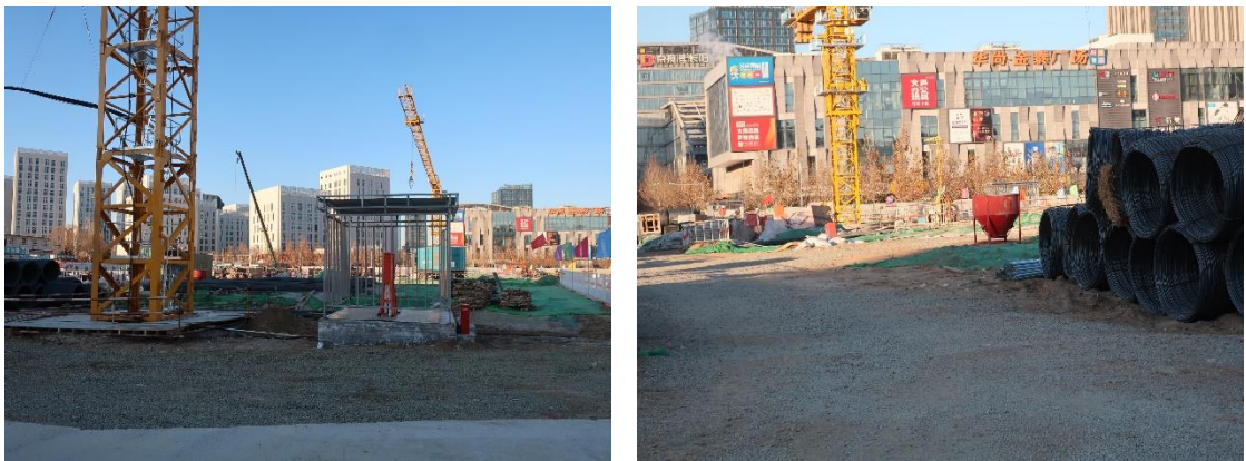
施工临建区碎石铺装
