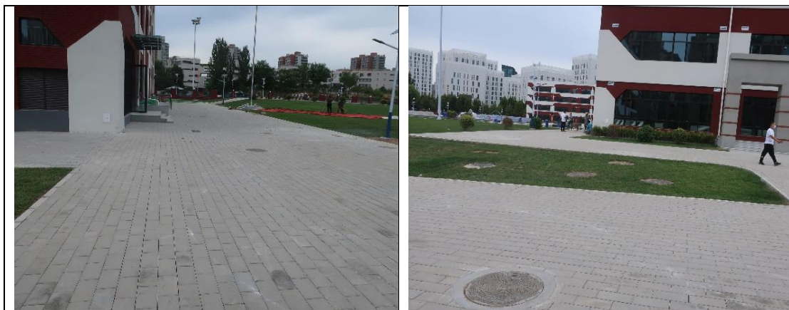
项目区南侧透水砖铺装（2022.9）
