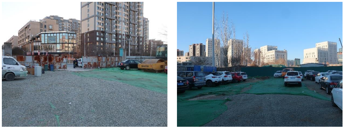
施工设施区碎石铺装
