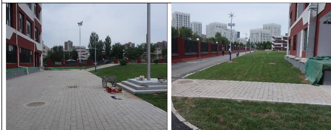
项目区南侧透水砖铺装（2022.9）
