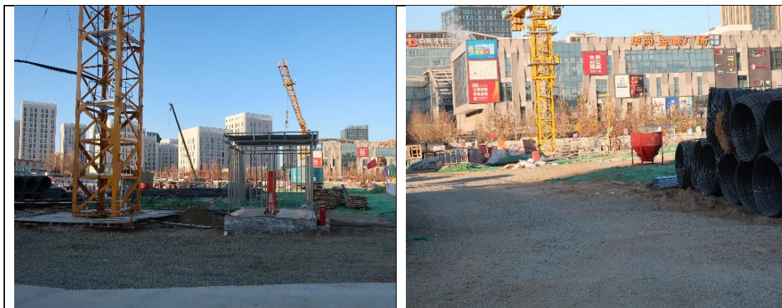
施工临建区碎石铺装 (2021.12)
