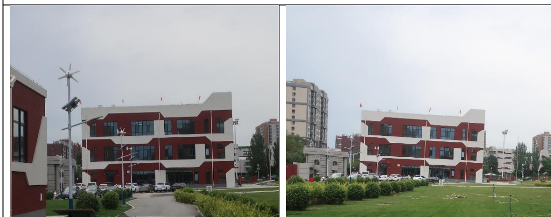
建筑物区文体综合楼（2022.9）
