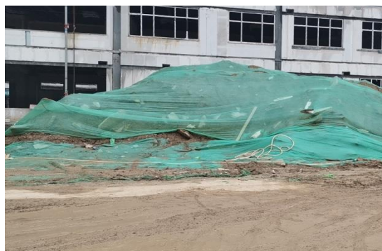
室外工程施工阶段临时覆盖
