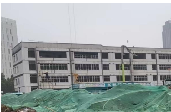
室外工程施工阶段临时覆盖
