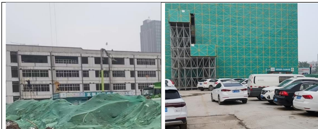
建筑物主体封顶（2022.7）
