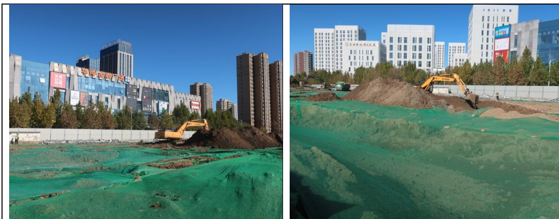
项目区北侧基坑开挖（2021.11）
