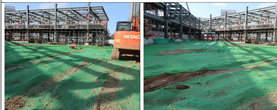
建筑物区外围裸露区域临时覆盖 2（2022.3）
