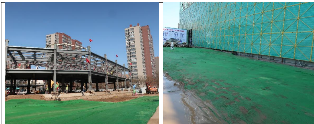
建筑物区外围裸露区域临时覆盖 1（2022.3）
