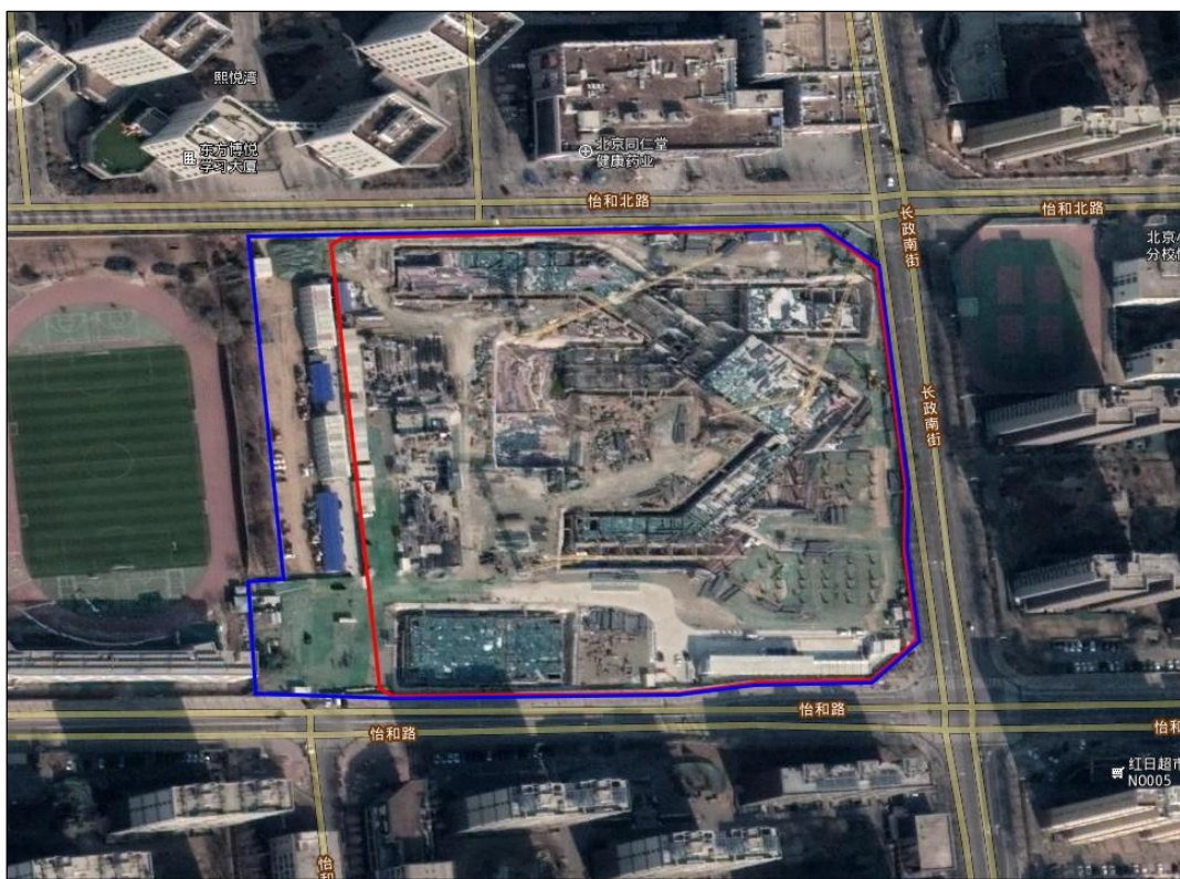
建筑物主体施工阶段遥感影像图（2022年2月10日）
