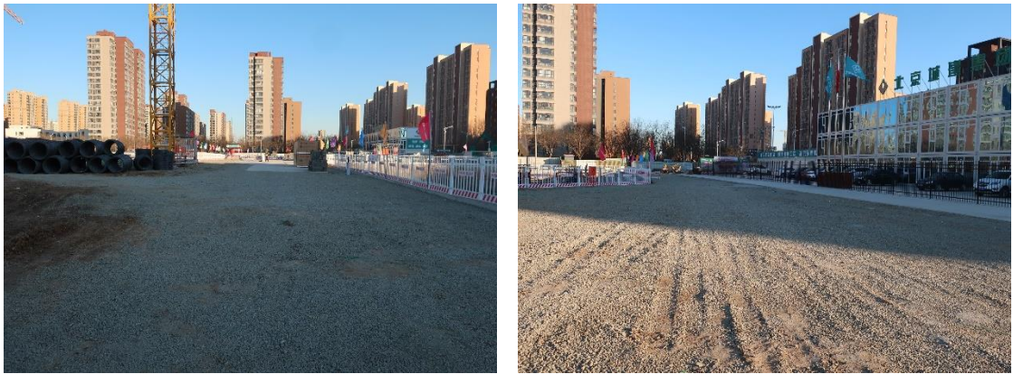
室外临时道路碎石铺装
