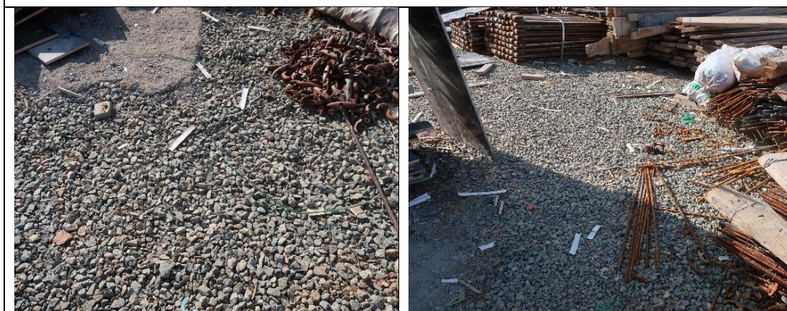
施工临建区碎石铺装（2022.3）
