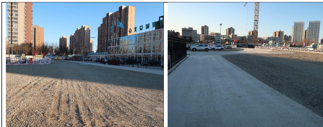
道路广场区碎石铺装 2 (2021.12)
