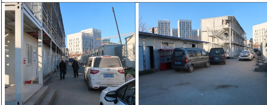
施工临建区临时硬化地面 2 (2021.12)
