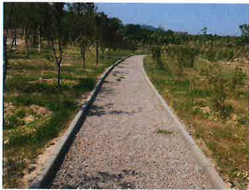
再生骨料碎石铺装
