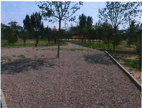
再生骨料碎石铺装
