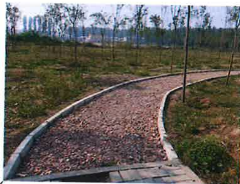
再生骨料碎石铺装
