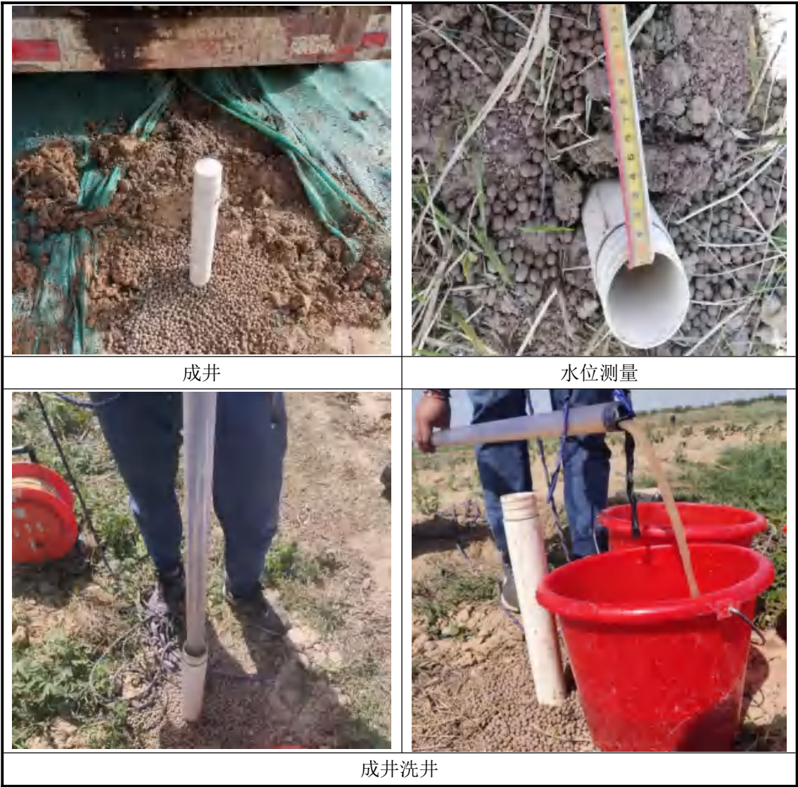
图 4.2-9 地块现场建井洗井照片
