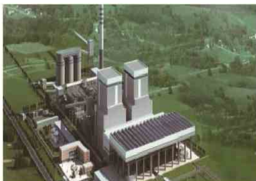
【项目】大唐锡林浩特电厂 【客户】中国能源建设集团江苏省电力建设第三工程有限公司 【规模】10万平方米
