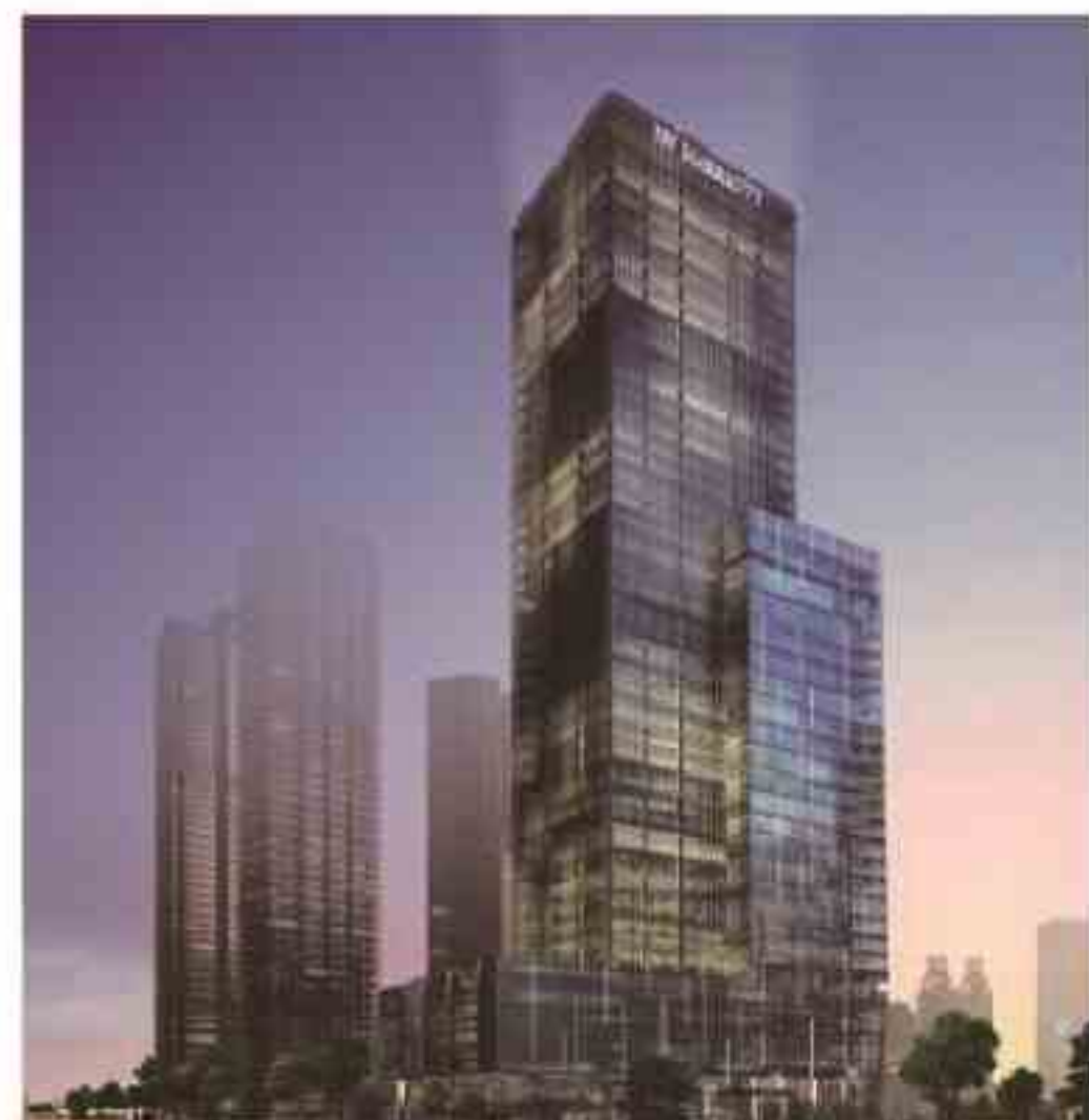
【项目】大连沿海国际中心 【客户】中建三局 【规模】16万平方米
