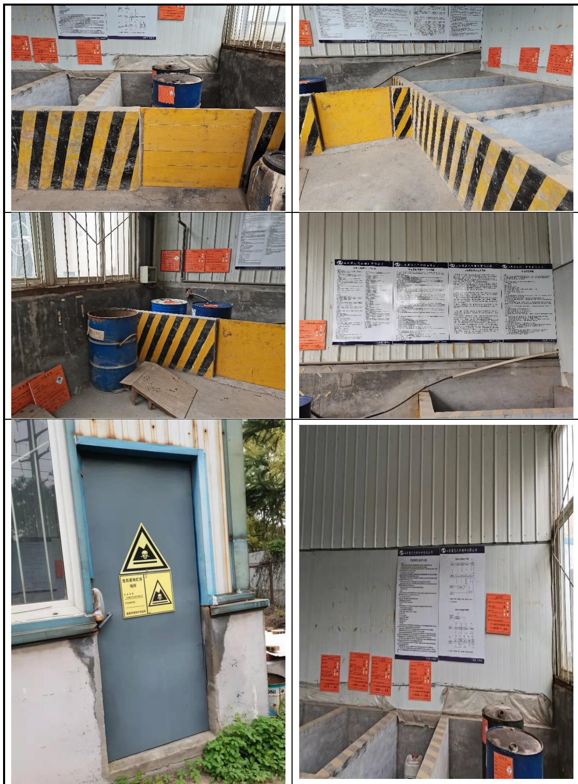
图 4-1 本项目危废暂存间现场图
